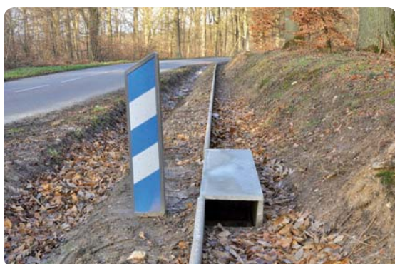
Vue sur une des entrées du crapauduc de la forêt de Carnelle
