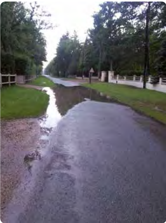
Stagnation des eaux pluviales dans le Lys-Chantilly.
