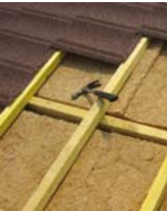
Isolation d'une toiture
