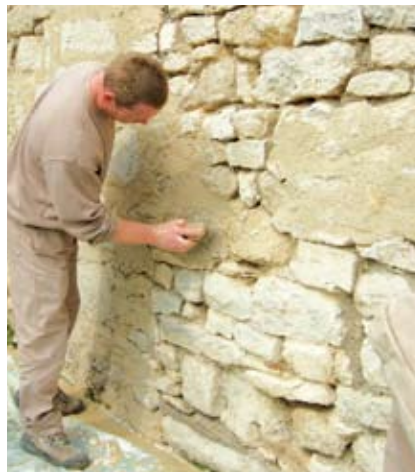
Rénovation à la chaux
