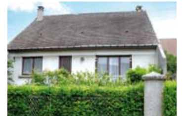
Maison de constructeur
