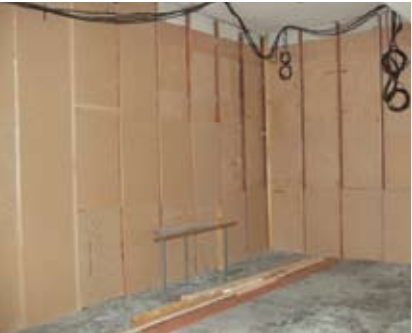
Isolation d'un mur
