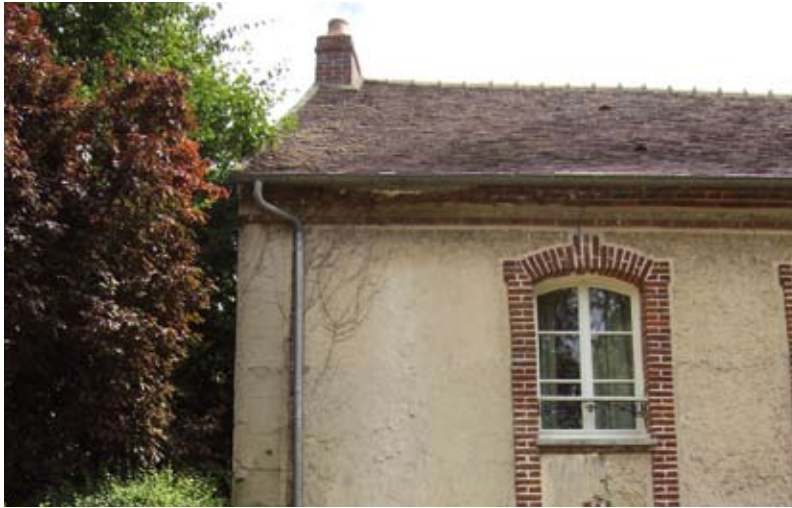
Fenêtre rénoverée (bois) double vitrage
