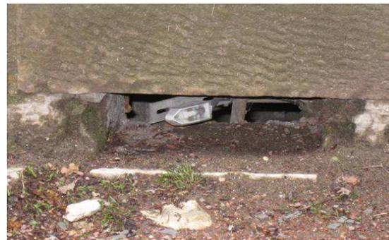
Sonde de luminosité à déplacer selon les recommandations constructeurs
