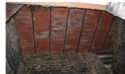
Plancher non isolé dans local non chauffé
