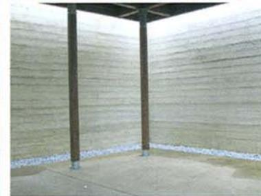
Abri composé de murs et sol en béton clair avec un fossé de gravillons qui reçoit les eaux de pluie provenant de l'ouverture entourant la toiture apportant un éclairage naturel
