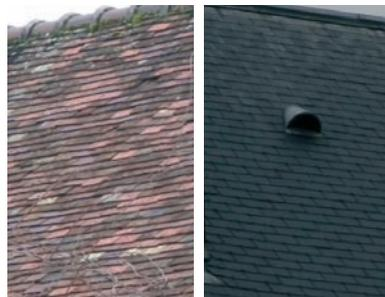
Les couvertures traditionnelles de Coye-la-Forêt sont en tuile plate de petit moule (60 à 80 au m<sup>2</sup> environ), le faitage est scellé au mortier clair avec des tuiles demi-rondes (faitage à crêtes et embarrures).
