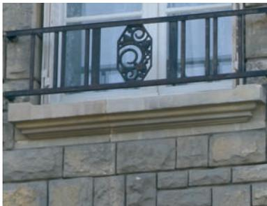
Sur les murs de moellon, appui de fenêtre, harpe et chaînage d'angle en pierre de taille renforcent la maçonnerie. Bandeaux en enduit lissé, corniches en brique argile, silico-calcaire ou vernissée ornent certaines façades.
