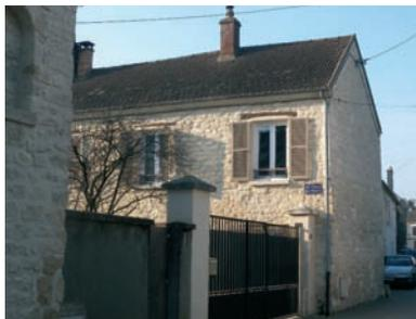
Les murs sont en pierre calcaire, les couvertures en tuile plate. Corniche, bandeaux et encadrements sont généralement en plâtre. Ces modénatures et le soubassement peuvent être aussi en enduit de chaux lissé.
