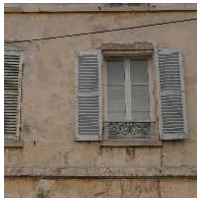
Les volets battants des fenêtres s'encastrent dans les feuillures ménagées à l'extérieur des tableaux pour éviter la prise au vent. Les planches des volets bois peint non verni sont assemblées par des barres horizontales sans écharpe (Z).
