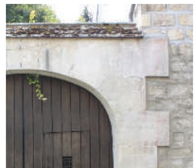
Les murs des clôtures sont protégés par des couronnements en pierre ou en tuiles, pour le rejet des eaux de pluie.
