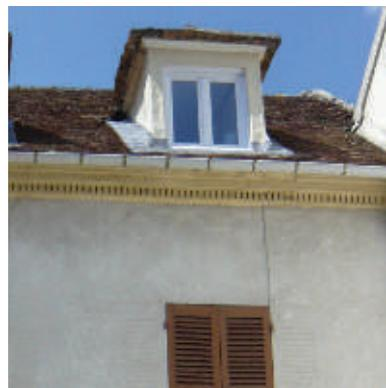
Les ouvertures en toiture présentent des formes variées : lucarnes, (capucines, jacobines, meunières, rampantes,...) oculi, fenêtres de toit et châssis à tabatière. Leurs menuiseries s'harmonisent avec celles des fenêtres de la façade.
