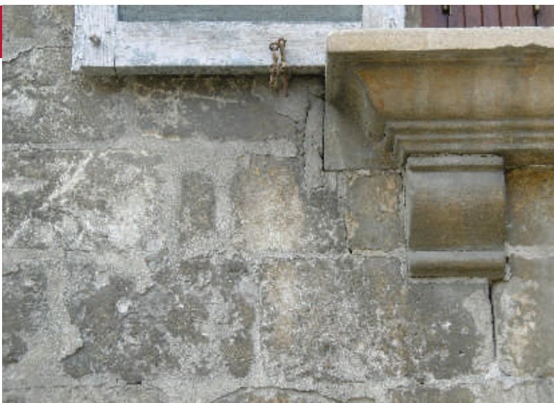
L'encadrement de fenêtre en pierre de taille ou en moellon enduit structure la baie, élément fragile de la façade. Les harpes, chaînages d'angle et soubassements, participent également à la structure du bâti. Ils sont généralement en pierre de taille ou en moellons appareillés. Un enduit lissé à la chaux naturelle protège le pied du mur des infiltrations et des rejaillissements d'eau pluviale lorsque la maçonnerie est en moellon.
