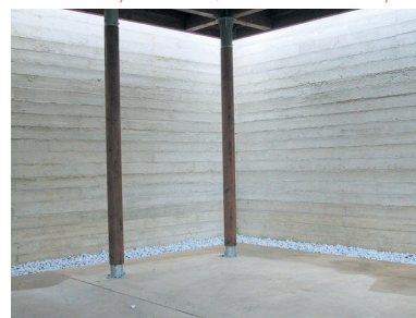
Préau aux Clayes-sous-Bois, archi. Anne Delaunay
