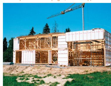
Chantier d'une maison à ossature bois
