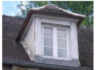
Les lucarnes sont en maçonnerie ou charpentées. Elles sont protégées par des enduits sur les jouées ou des couvertures de terre cuite ou en ardoise. Du zinc complète les protections.
