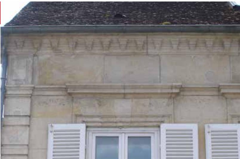
Les ouvertures dans les façades contribuent à rendre le mur plus fragile. Parfois, des tirants métalliques dont les ancrages sont visibles en façade relient la charpente à la maçonnerie. Les baies sont consolidées par des linteaux (à claveaux, en brique, en bois, en métal). Les encadrements de baie sont construits de pierre de taille et de brique. Des barres d'appui ou des garde-corps équipent les baies.
