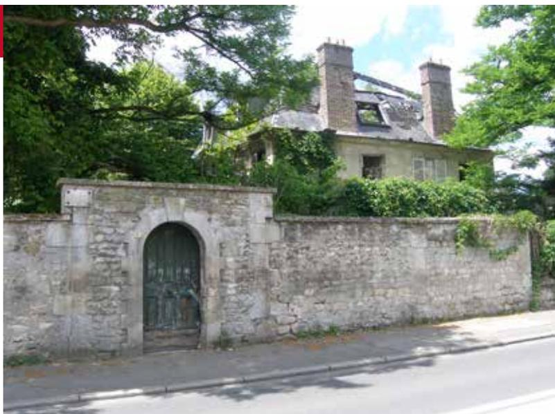
Le mur traditionnel est construit en moellon calcaire et grès. Souvent d'un grand linéaire, il est renforcé régulièrement par des chaînes verticales harpées qui le rigidifient. Peu enduit, il est protégé des intempéries par un chaperon en tuile ou par un couronnement de pierre ou maçonné. Les accès qui le ponctuent sont intégrés à la structure qui assure la continuité de la lisibilité d'ensemble.
