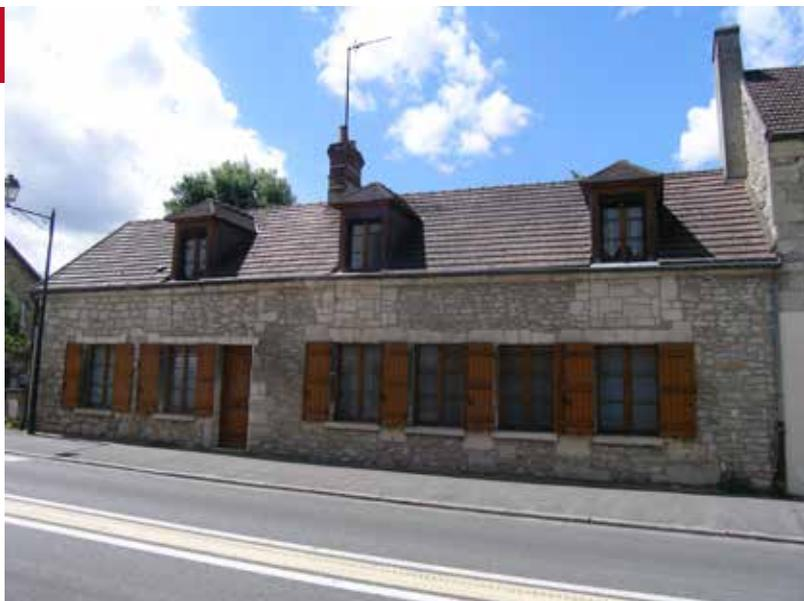
La façade urbaine de la maison rurale se caractérise par la présence d'une porte piétonnière, étroite, disposée souvent dans l'axe ou légèrement déportée, ou exceptionnellement rejetée à une des extrémités. Un seuil en pierre monolithe a souvent été remplacé par une surface en béton.
