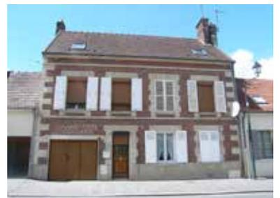
La période consacrée à l'édification de la typologie a permis son enrichissement, et c'est ainsi que les parements, traditionnellement construits en pierre de taille apparente ou en moellons enduits à la chaux, sont parfois remplacés par de la brique pour les parties courantes.
