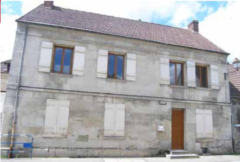
La maison de bourg peut représenter un gabarit imposant avec plusieurs travées dont les deux niveaux sont séparés par un simple bandeau plat, ils sont coiffés en tête par une corniche en pierre de taille souvent chanfreinée. Les linteaux sont à claveaux et les appuis de fenêtre fins en pierre monolithe. Les appareils de pierre posés à joints croisés sont de dimension moyenne. Un simple soubassement en légère saillie assure l'assise.
