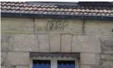
Les modénatures (corniche, appui de baie) éloignent les eaux de pluie de la façade. Essentiellement en pierre, très rarement en enduit, ces éléments constituent des renforts structurels dans une façade (jambage, linteau, appui, soubassement).
