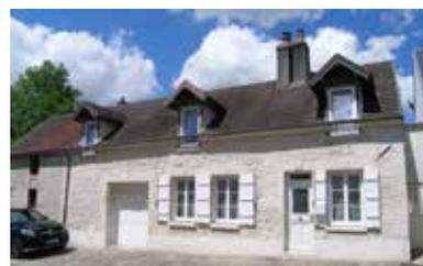
Les maisons rurales, bâties en mitoyenneté, alignent des murs en pierre calcaire appareillée, de fins bandeaux intermédiaires et une corniche moulurée (doucine, chanfrein). Certaines élévations sont construites en moellons calcaires recouverts d'un enduit couvrant ou « à pierre-vue » mais sont renforcées par des éléments en appareil de pierre apparente (linteau, encadrement, appui, chaîne d'angle, corniche).
