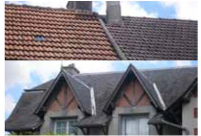
Les couvertures traditionnelles sont en tuile plate petit moule (60 à 80 au m<sup>2</sup>). La tuile plate plus moderne ou la tuile mécanique est venue renouveler les versants dès le milieu du 20<sup>e</sup> siècle, ou en ardoises avec le développement des toitures à la «Mansart» sur les maisons XIX<sup>e</sup>-XX<sup>e</sup>.
