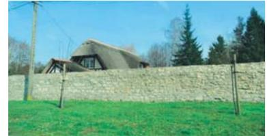
Traditionnellement, les murs construits en moellon calcaire et grès sont peu enduits. Ils sont protégés des intempéries par un chaperon en enduit, parfois par de tuiles mécaniques ou par un couronnement en pierre.
