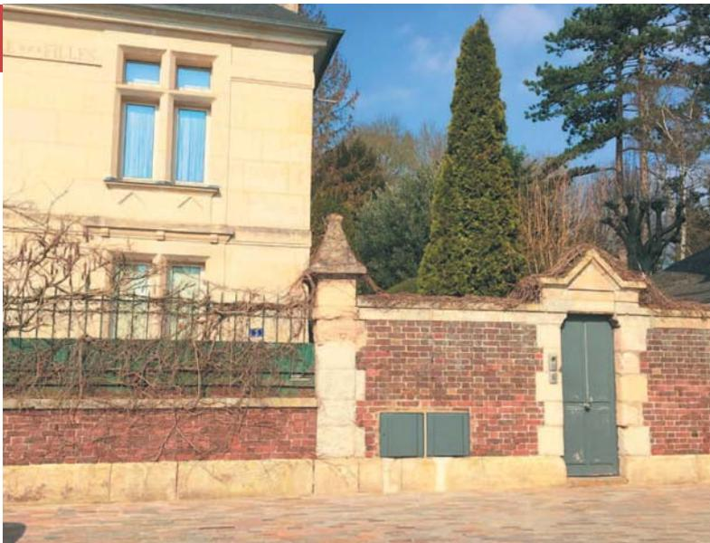
Certains ouvrages de clôtures sont très soignés : tête de mur protégée par un couronnement en pierre en saillie pour rejeter les eaux de pluie, piles en pierre de taille moulurée avec chapiteau sculpté, mur bahut en pierre de taille ou brique surmonté de ferronnerie.
