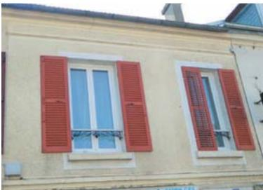
Les roches calcaires tirent leur coloration claire et uniforme blanc-jaunâtre de leur composition (carbonate de chaux mélangé à de l'argile, de la magnésie, de la silice, des oxydes...). La couleur des mortiers de chaux et plâtre se rapproche de celle de la pierre. Elle prend une plus grande importance visuelle sur les parties enduites que sur la pierre de taille, où les joints sont minces et à peine apparents.
