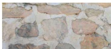
Les murs en pierre de taille, en moellon layé ou bosselé ne sont pas enduits, laissant apparaître l'appareillage et la finesse de mise en œuvre des joints au mortier de chaux selon les appareillages et l'effet souhaité.
