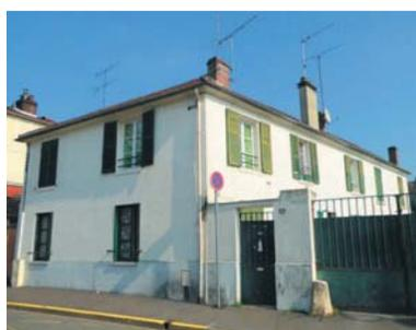
La construction forme un parallépipède rectangle sur deux niveaux, surmontés d'un toit à deux pans allant de 35° à 45° rythmé par des souches de cheminées en brique ou pierre calcaire.
