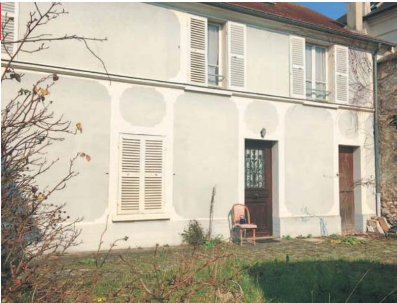
La façade est souvent composée de trois ou quatre travées, pas toujours ordonnancées. Les maçonneries, généralement en moellon calcaire, sont recouvertes par un enduit couvrant à la chaux. Traditionnellement, les corniches et les bandeaux sont en plâtre.
