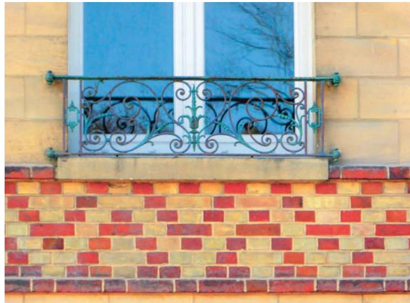
Les compositions de façades, mêlant plusieurs matériaux, sont fréquentes. La pierre de taille, la brique, parfois l'enduit, peuvent être recouverts d'un badigeon protecteur. Les enduits, anciens ou plus contemporains, recouvrent la maçonnerie en totalité. Protecteurs, ils protègent des infiltrations, parfois du sel et des chocs thermiques.
