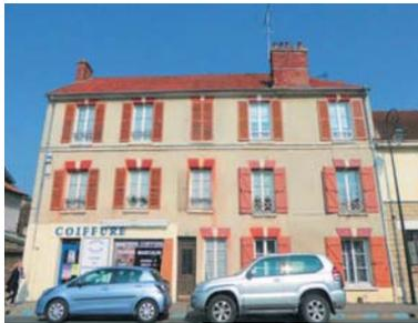
La construction forme un parallélépipède rectangle simple sur deux ou trois niveaux. Elle est généralement surmontée d'un toit à deux pans de 35°. Les souches de cheminées sont positionnées dans le prolongement des pignons ou au niveau des murs de refend.
