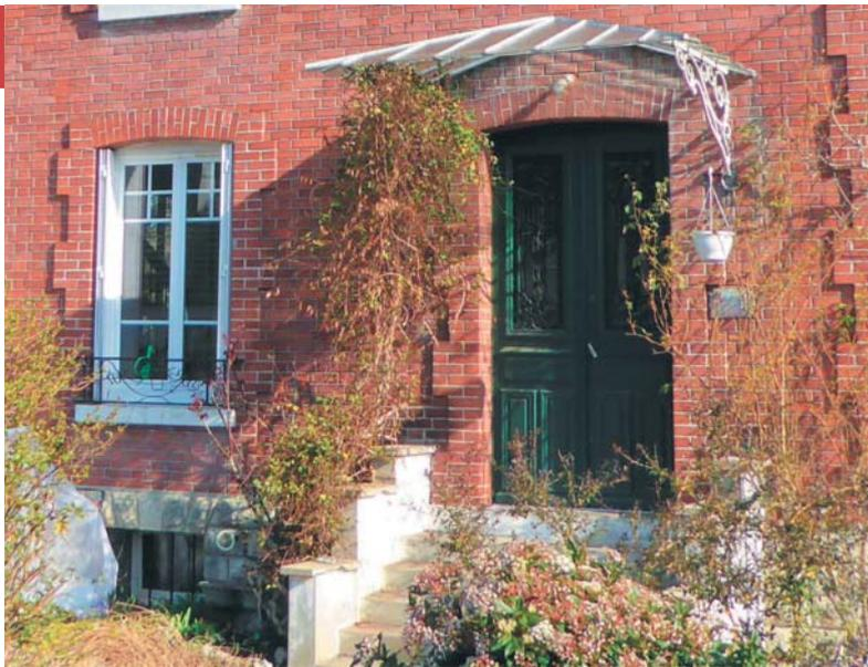
Un perron maçonné marque parfois l'entrée des maisons quand le rez-de-chaussée est surélevé. La porte d'entrée avec une partie haute vitrée est protégée par une marquise en verre et métal.
