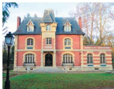
Les ouvertures sont diverses par leurs formes et dimensions : baie cintrée, porte-fenêtre avec balcon en bois, fenêtre à multiples vantaux, oriel, lucarne rampante, jacobine, œil-de-bœuf ou capucine... Les menuiseries sont le plus souvent à petits bois à plusieurs divisions de carreaux.
