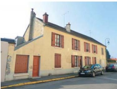
La tuile plate, le grès et le moellon calcaire enduit sont les matériaux de construction traditionnels des maisons rurales.
