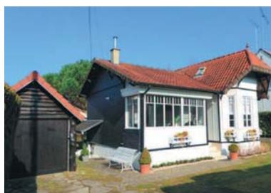
La tuile mécanique, le zinc, la pierre calcaire, la brique et plus rarement la meulière sont les matériaux de construction traditionnels de ces maisons. La brique en argile, silico-calcaire ou vernissée participe souvent au décor des corniches, des linteaux, des appuis, des encadrements ou des bandeaux. Un soubassement en saillie protège en pied de mur des rejaillissements d'eau.
