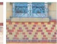
Les encadrements de fenêtre sont constitués de pierre de taille, de moellon enduit ou de brique formant des décors. Des feuillures permettent d'encastrer les volets dans le tableau. Ferronneries ou garde-corps en bois agrémentent les baies.
