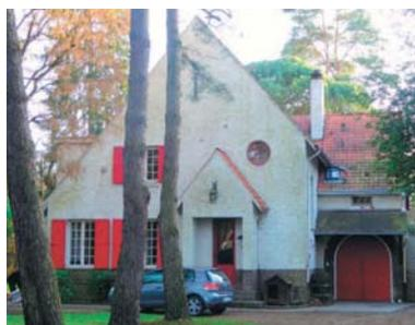
La tuile mécanique, l'ardoise, le zinc, les faux pans de bois en enduit teinté, le bois, la brique, la pierre de taille, le moellon équarri ou bosselé, l'enduit lissé ou tyrolien sont les matériaux de construction caractéristiques des maisons du Lys des années 20 - 40.
