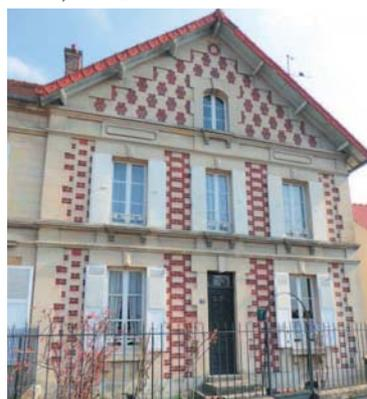
Les baies fermées par des persiennes métalliques pliantes ou par des volets en bois sont agrémentées de ferronneries formant garde-corps. Les façades sont protégées de la pluie par des débords de toit importants.
