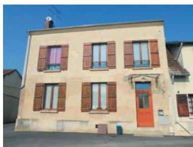
La tuile plate en terre cuite, le moellon calcaire enduit et la pierre de taille constituent les matériaux de construction des maisons de bourg.
