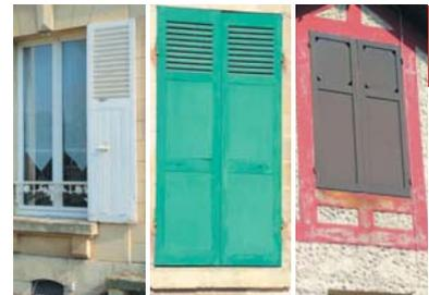
Des feuillures permettent d'insérer les volets dans le tableau des fenêtres afin d'atténuer la prise au vent.
