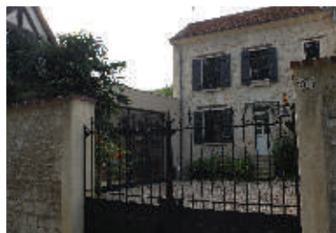
Extension à Asnières-sur-Oise
