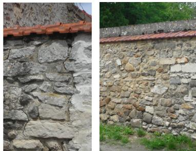
Les murs sont construits en moellon calcaire et grès.
