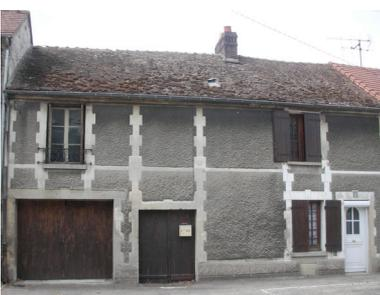
La tuile plate et le moellon calcaire enduit sont les matériaux de construction traditionnels des maisons rurales. La façade sur rue est recouverte entièrement d'un enduit. Des corniches, des bandeaux, des harpes de chaînage, des appuis de fenêtre structurent la façade, ils sont soulignés par un enduit lissé. Un enduit chaux ou bâtard taloché protège parfois la partie basse du mur.
