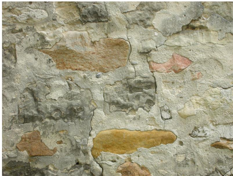
Autrefois, les enduits, teintés en ocre jaune, gris bleuté ou autres, étaient totalement couvrant (au mortier de chaux ou plâtre gros selon le cas) sur les moellons gélifs. Quelques têtes saillantes de moellon grès restaient visibles sur certains murs, mais les pierres calcaires devaient être protégées par un enduit.
