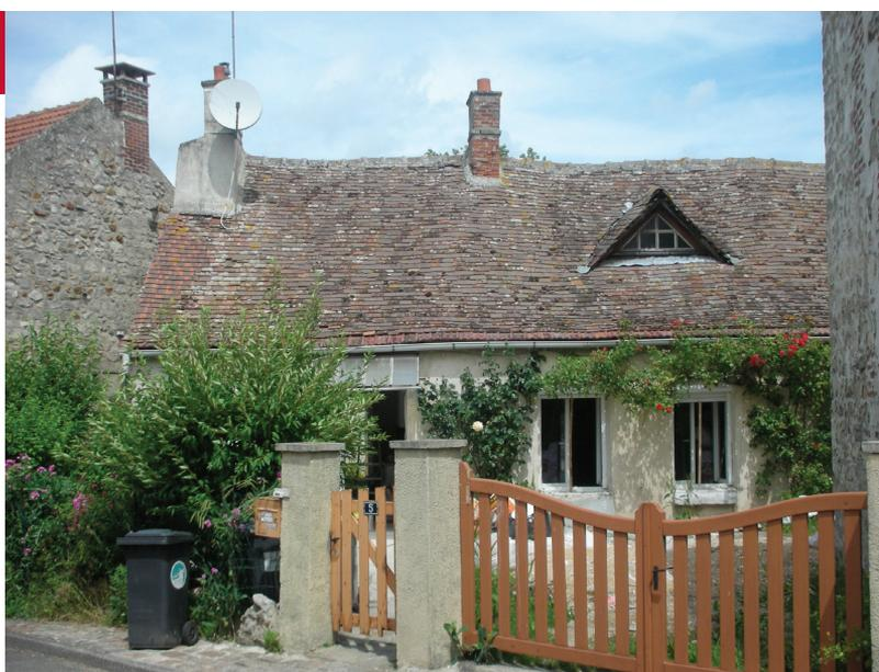
La façade était toujours protégée par un enduit recouvrant les moellons et les linteaux en bois des ouvertures. Une fenêtre à engranger éclaire les combles traditionnellement inhabités. Elle présente la même largeur que la fenêtre du rez-de-chaussée et une hauteur qui correspond à la distance entre le plancher de l'étage et la panne sablière de la toiture.
