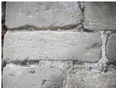
Les murs, les piles ou parties de façade réalisés en pierre de taille, brique ou moellon équarri non gélif ne sont pas enduits, laissant visible l'appareillage et les joints au mortier de chaux.
