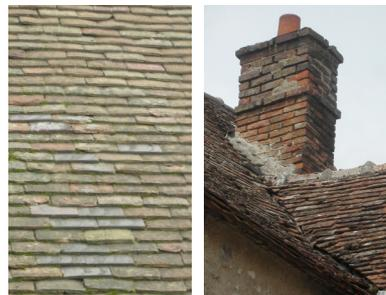
Les couvertures traditionnelles de Pontarmé sont en tuile plate petit moule (60 à 80 au m<sup>2</sup> environ), le faîtage est scellé au mortier clair avec des tuiles demi-rondes (faîtage à crêtes et embarrures).
