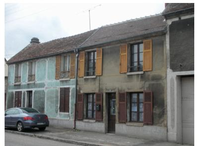
Les corniches en plâtre sont moulurées. Les appuis de fenêtre sont en pierre.
