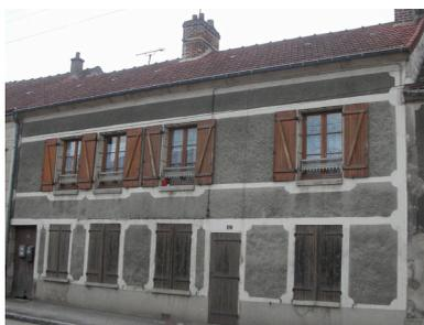
Les murs sont en pierre calcaire. Aujourd'hui les couvertures, traditionnellement en tuile plate, sont parfois couvertes en tuile mécanique.
