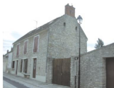
Les pignons visibles comportent peu d'ouvertures. Traditionnellement inhabité, le comble n'est éclairé que par des châssis à tabatière de petites dimensions.
