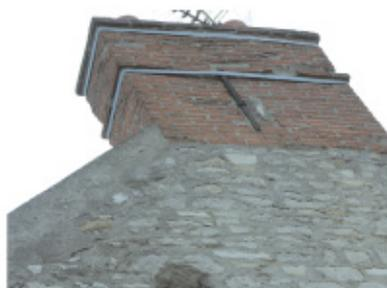
Les façades ou parties de façades réalisées en pierre de taille ne sont pas enduites, laissant visible l'appareillage et la finesse des joints au mortier de chaux.
