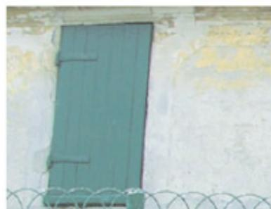
Les anciennes ouvertures à engranger (engagées dans le mur) sont fermées par un simple contrevent à un battant.
