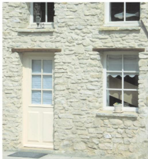
Les enduits sont appliqués soit partiellement (enduit de restauration à pierre-vue avec des joints arasés au nu de la maçonnerie), soit totalement (enduit couvrant au mortier de chaux grasse ou au plâtre gros, selon les cas). Parfois, ces enduits couvrants sont teintés en ocre soutenu.
