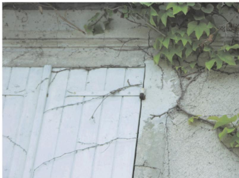
Quand l'encadrement est en pierre de taille appareillée, celui-ci n'est pas enduit. Un soubassement en enduit bâtard lissé protège parfois le pied du mur contre les infiltrations et les rejaillissements d'eau pluviale.
