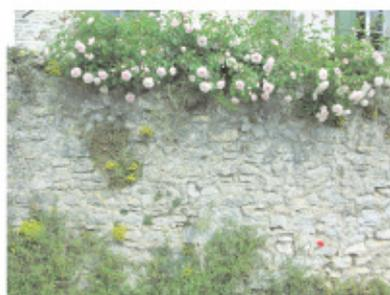
Les murs en pierre sont montés traditionnellement avec des moellons trouvés dans les terres cultivées de Montlognon. Ils peuvent être enduits ou non, parfois montés avec très peu de mortier avec un aspect proche de celui de la pierre sèche.
