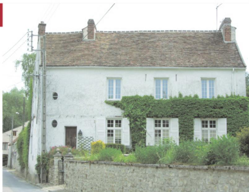
Les façades des grandes demeures sont ordonnancées : alignement horizontal des linteaux et des appuis, superposition et hiérarchisation des fenêtres. Les pignons comportent peu d'ouvertures.
