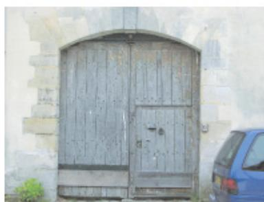
Une porte charretière ancienne remarquable subsiste sur une des grandes demeures de la rue principale de Montlognon. Réalisée par l'assemblage de planches verticales en bois plein sur une ossature, elle ferme le passage cocher qui donne accès au jardin derrière..
