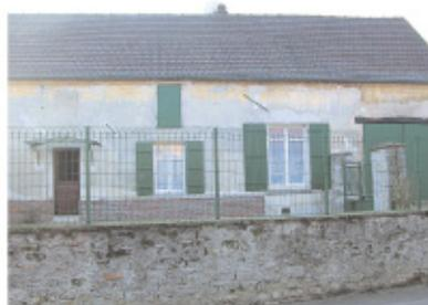
La tuile plate et le moellon calcaire enduit totalement ou partiellement (enduit à pierres vues) sont les matériaux de construction traditionnels des longères. Certains pignons sont montés en pierres sèches. Les murs sont sobres, dépourvus de modénature. Ils ne comportent notamment pas de corniche. Parfois, un enduit bâtard taloché protège la base du mur.
