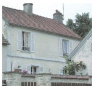
Les chaînages et encadrements de baies sont recouverts en enduit lissé. On observe des bandeaux et des corniches en plâtre, pierre ou enduit. Un enduit bâtard taloché protège parfois la partie basse du mur formant un soubassement.
