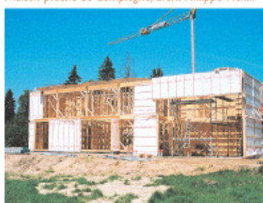
Chantier d'une maison à ossature bois
