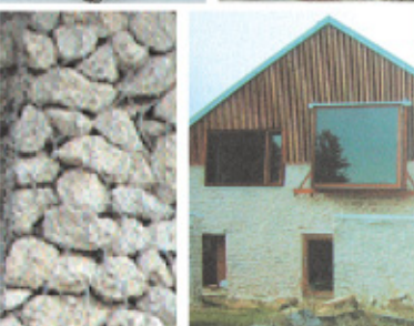
Matériaux : résilles métalliques pour plantes grimpantes, mur en gabion (caisson en treillage métal rempli de caillasse), pignon en moellon enduit à pierre vue et clins de bois associés aux fenêtres cadrées
