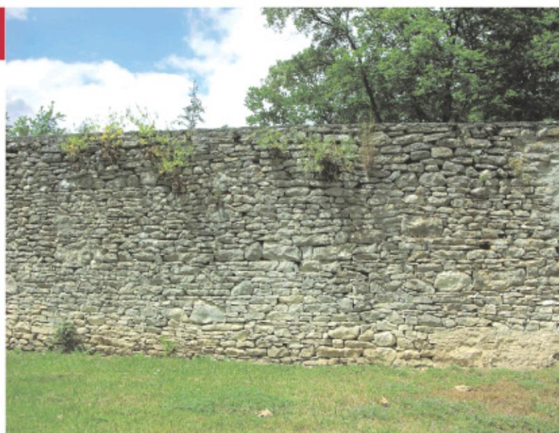
Ces murs étaient autrefois très ouvragés : tête de mur réalisée par un chaperon convexe de moellons ou une dalle de pierre en saillie, rangs de tuiles plates pour rejeter les eaux de pluie. Lorsque les murs présentent une certaine longueur, des jambes harpées et des chaînages aux angles les consolident.
