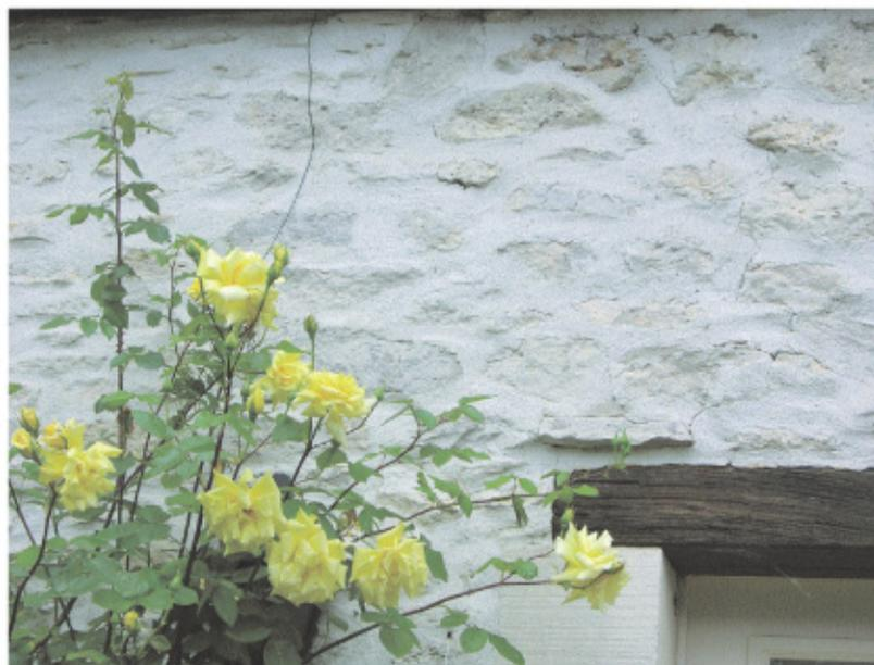
Les enduits sont appliqués soit partiellement (enduit de restauration à pierre vue avec des joints arasés au nu de la maçonnerie), soit totalement (enduit couvrant au mortier de chaux grasse ou au plâtre gros, selon les cas). Parfois, ces enduits couvrants sont teintés : en ocre rouge, gris bleuté...
