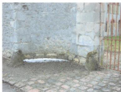
Les murs ou parties de façades réalisés en pierre de taille ne sont pas enduits, laissant visible l'appareillage et la finesse des joints au mortier de chaux.
