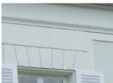
Sur les murs de moellons, harpes et chaînage d'angle en pierre de taille viennent renforcer la maçonnerie.
