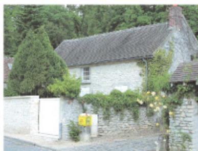
Les chaînages et encadrements de baies sont rares, ils sont réalisés en moellons équarris. On observe des linteaux de bois recouverts à l'origine. Les appuis de fenêtres sont souvent formés par des pierres plates. Un enduit bâtard taloché peut protéger la partie basse du mur formant un soubassement.
