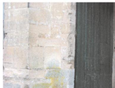
La couleur du mortier se rapproche de celle de la pierre. Elle prend une plus grande importance visuelle sur les murs en moellons que sur les murs en pierre de taille où les joints sont minces et à peine apparents.
