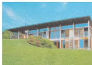
Maison intégrée au site naturel, avec utilisation passive de l'énergie solaire, une isolation renforcée, des doubles vitrages isolants, un jardin d'hiver, une mise en œuvre de matériaux recyclables et des finitions saines, un choix d'essences de bois naturellement durables, l'épuration des eaux usées et des eaux vannes par des lits à macrophytes
