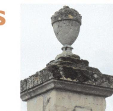
Les murs en pierre sont montés traditionnellement avec des moellons trouvés dans les terres cultivées de Fontaine-Chaâlis. Ils peuvent être enduits ou non, parfois montés avec très peu de mortier avec un aspect proche de celui de la pierre sèche.
