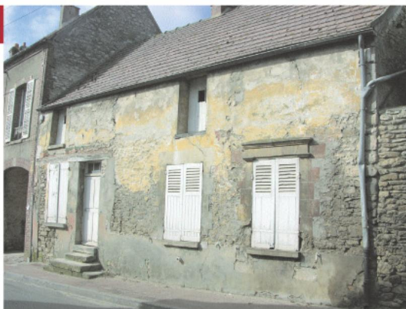
Les portes et les fenêtres n'occupent qu'une surface réduite de la façade et présentent un certain ordonnancement : alignement horizontal des linteaux au rez-de-chaussée, superposition des fenêtres à engranger dans l'axe des fenêtres du rez-de-chaussée.
