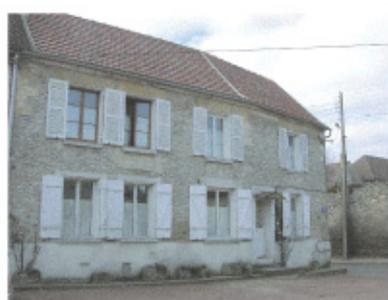
La construction forme un parallélogramme rectangle de dimensions variables surmonté d'un toit à deux pans dont la pente est parfois inférieure à 45°.
