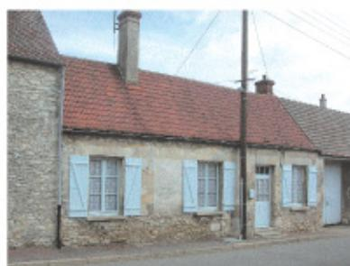
La tuile plate et le moellon calcaire enduit totalement ou partiellement (enduit à pierres vues) sont les matériaux de construction traditionnels des longères. Certains pignons sont montés en pierres sèches. Les murs sont sobres, dépourvus de modénature. Ils ne comportent notamment pas de corniche. Parfois, un enduit bâtard taloché protège la base du mur.
