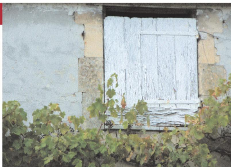
Pour les habitations les plus modestes, les volets sont réalisés en bois peint non verni sous forme de planches assemblées par des barres horizontales sans écharpe. Les volets en bois peuvent être persiennés (sur la moitié de leur hauteur au rez-de-chaussée, en totalité à l'étage). On observe la présence de volets pliants métalliques aux fenêtres des maisons de village datant de la fin du XIX<sup>ème</sup> siècle ou du début du XX<sup>ème</sup> siècle.
