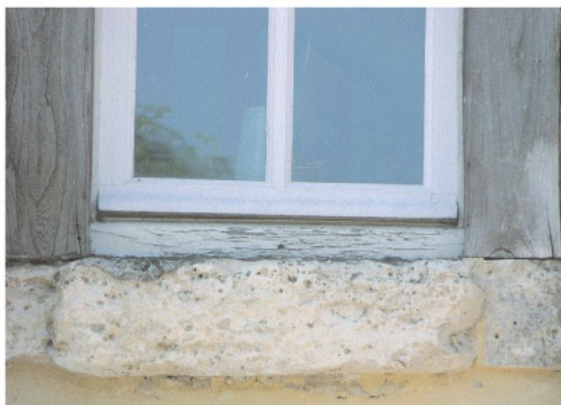
Les appuis de baies sont réalisés traditionnellement avec une pierre monolithe en débord, parfois avec des briques.
