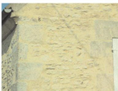
Quand l'encadrement est en pierre de taille appareillée, celui-ci n'est pas enduit. Les encadrements de fenêtre en briques présentent des aspects variés et parfois un profil légèrement cintré.
