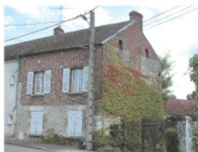
Quand la brique n'est pas présente, les chaînages et encadrements de baies sont réalisés en pierre de taille. On observe des bandeaux et des corniches en plâtre, pierre ou brique. Un enduit bâtard taloché protège parfois la partie basse du mur formant un soubassement.
