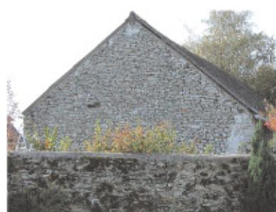
Ces murs étaient autrefois très ouvragés : tête de mur réalisée par un chaperon convexe de moellons ou une dalle de pierre en saillie pour rejeter les eaux de pluie, piliers avec un couronnement mouluré et un ébrasement avec une feuillure.
