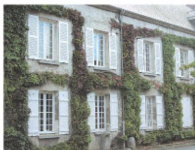
En façade des grandes demeures, la teinte de la pierre calcaire apparente domine. Les couvertures peuvent être en tuile ou en ardoise. Les encadrements et appuis de fenêtres, l'arc du portail, les chaînages et harpes sont traités en pierres de taille soigneusement appareillées.
