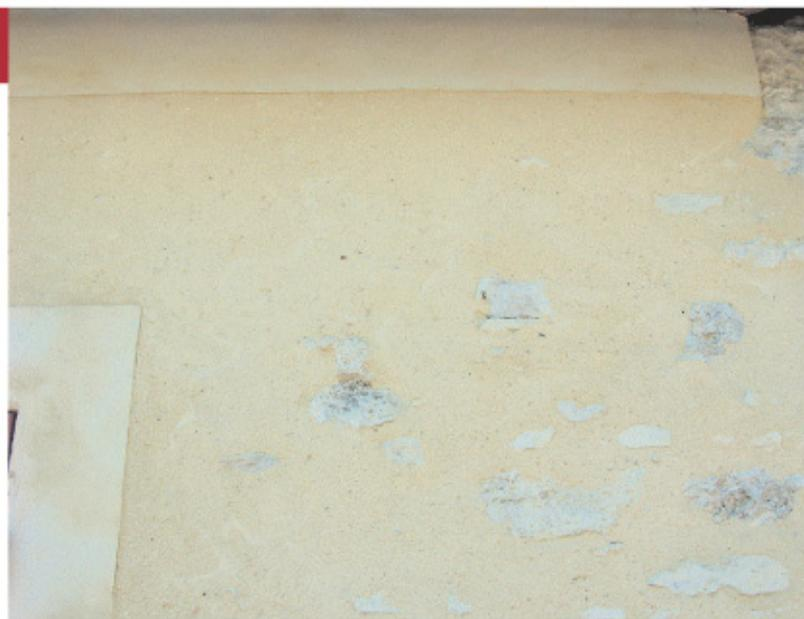
Les enduits sont appliqués soit partiellement (enduit de restauration à pierre-vue avec des joints arasés au nu de la maçonnerie), soit totalement (enduit couvrant au mortier de chaux grasse ou au plâtre gros, selon les cas). Parfois, ces enduits couvrants sont teintés en ocre jaune soutenu.
