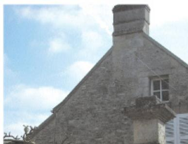
Les couvertures traditionnelles de Rully et de Bray sont en tuiles plates de petit moule (60 à 80 au m<sup>2</sup> environ), le faitage est scellé au mortier clair avec des tuiles demi-rondes (faitage à embarrures). Les rives sont souvent protégées par un solin de plâtre appelé la ruellée. Celle-ci empêche la pluie de s'infiltrer sous la toiture.
