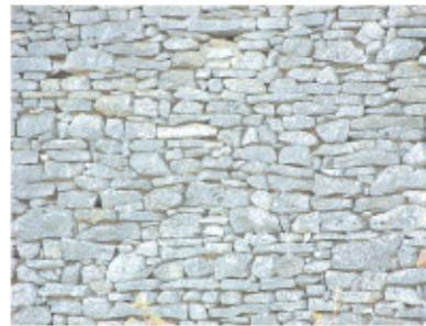
Certains murs de pignons, de granges ou de clôture sont montés à pierre sèche (sans mortier ou presque) avec des pierres relativement plates. Ils font également partie de l'identité de Rully.
