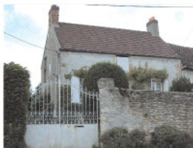
La construction forme un parallélogramme rectangle étroit surmonté d'un toit à deux pentes à 45° encadré par des souches de cheminées établies dans le prolongement des pignons.
