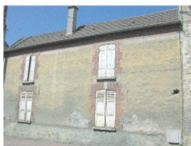
La tuile plate et le moellon calcaire enduit totalement ou partiellement (enduit à pierres vues) sont les matériaux de construction traditionnels des maisons rurales. Les murs sont sobres, les modénatures rares. Un simple bandeau lissé peut tenir lieu de corniche. Un enduit bâtard taloché protège parfois la partie basse du mur.
