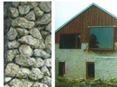
Matériaux : résilles métalliques pour plantes grimpantes, mur en gabion (caisson en treillage métal rempli de caillasse), pignon en moellon enduit à pierre vue et clin de bois associés aux fenêtres cadrées
