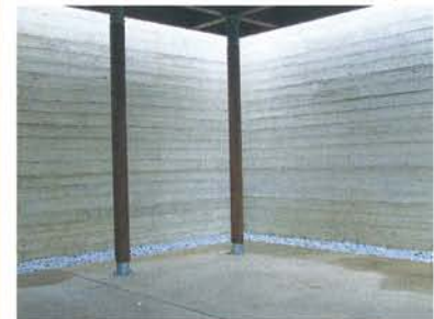
Préau aux Clayes-sous-Bois, archi. Anne Delaunay
