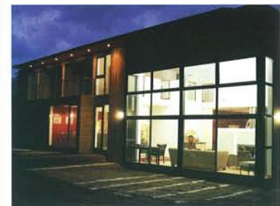
Construction avec installation d'un chauffage par géothermie (utilisation de l'énergie thermique du sol)
