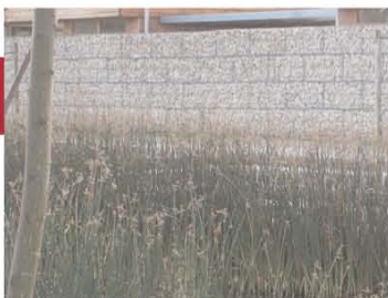
Les murs traditionnels des talus de Ver sont montés en grès en pierre sèche. La technique des murs en gabion est une solution pour monter un mur servant de soutènement aujourd'hui.
