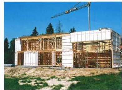
Chantier d'une maison à ossature bois
