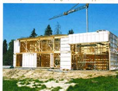
Chantier d'une maison à ossature bois
