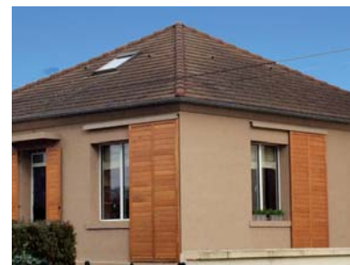
Maison des années 60 réhabilitée avec un enduit de teinte soutenue, de nouvelles menuiseries et des volets en bois coulissants
