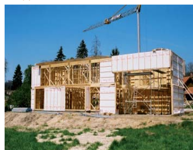
Chantier d'une maison à ossature bois
