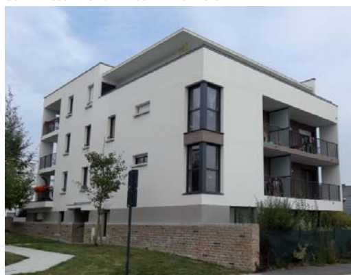
Construction de logements sur 4 niveaux alliant matériaux contemporains et traditionnels, Servon-sur-Vilaine archi. Jam Architecture Territoires
