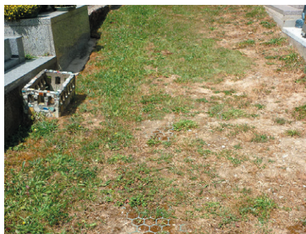
Sol enherbé renforcé par une nappe alvéolaire dans une allée du cimetière de Seraincourt (95).
