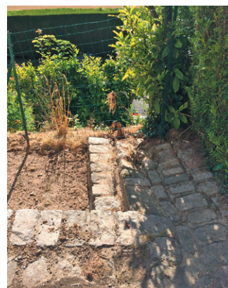
Jeu de caniveaux en pavés de grès au cimetière de Saint-Vaast-de-Longmont (60) évacuant l'eau vers l'extérieur.
