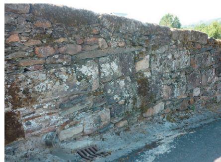
À Donzenac (19), le mur du vieux cimetière épousant la pente du coteau, est partiellement construit avec des sarcophages.
