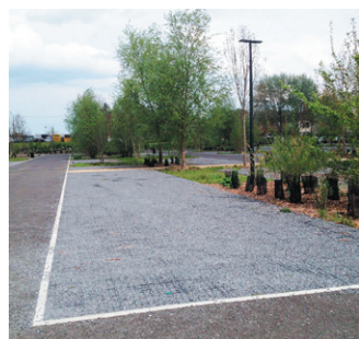
Sol mixte en émulsion gravillonnée et gravillons.
