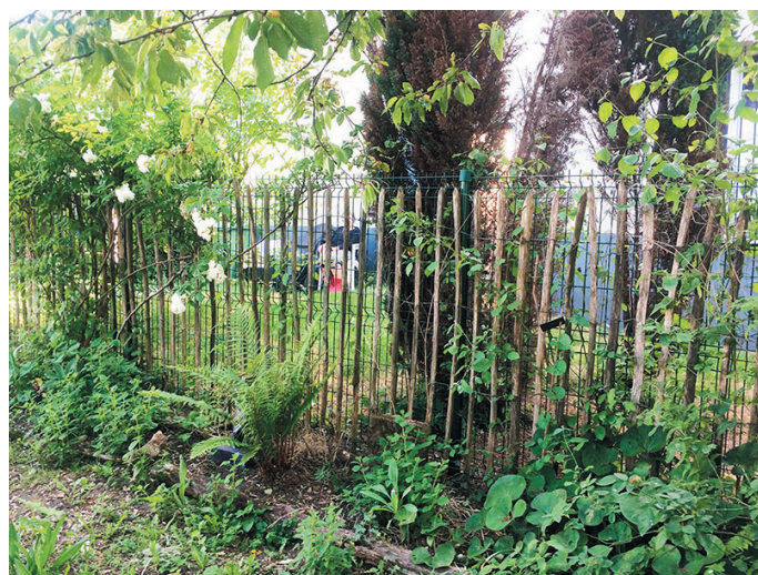
Doublage d'une clôture en treillis soudés par une clôture en échals de châtaignier accompagnée de plantes vivaces et de rosiers grimpants.
