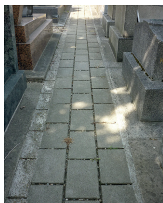
Dalles-béton recouvrant les petites allées en intertombes au cimetière de Montreuil-sous-Bois (93).
