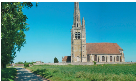
À Montagny-Sainte-Félicité (60), le cimetière entoure l'église monumentale, en isolat dans la plaine. Cette configuration séculaire en fait un lieu unique et remarquable.
