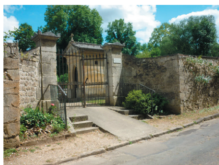
Rampe de franchissement des trois marches à l'entrée du cimetière de Vallangoujard (95). Ici aussi l'espace disponible pour l'accès est exigu. La rampe n'est pas aux normes mais permet une circulation plus aisée.
