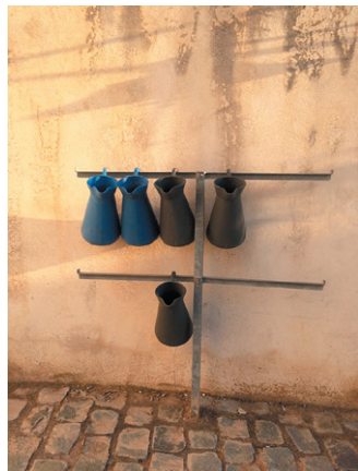
Cimetière de Sète (34). C'est une fontaine monumentale qui, placée près de l'entrée, offre de l'eau pour arroser les fleurs du cimetière. La fontaine intègre un reposoir en pierre sous le bouton poussoir, qui permet de poser les récipients lorsqu'on les remplit. Plusieurs supports très simples supportant des brocs à eau sont disposés dans le cimetière ; ils sont réalisés avec 3 cornières métalliques.
