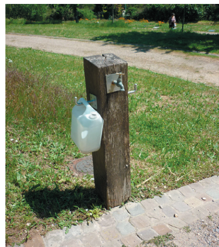
Au cimetière de Verrières-le-Buisson (91), une simple borne en bois et un caniveau en pavés de grès.
