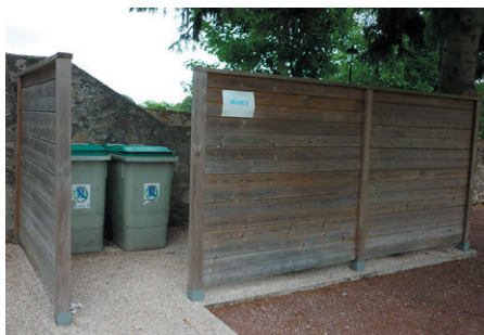
À Plailly (60), les conteneurs du tri sélectif sont disposés contre le mur et partiellement occultés par une clôture en bois, adossée à un bel if. Un sol en béton désactivé facilite le nettoyage de l'aire et la récupération des conteneurs. Quelques plantes grimpantes pourraient être installées pour agrémenter le dispositif.
