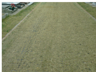
Au cimetière de l'Ouest à Angers (49), de nombreuses allées sont en pelouses avec résilles alvéolaires de stabilisation.
