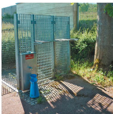
Aux Clayes-sous-bois (78), une borne fontaine est associée à chaque unité de tri des déchets. L'ensemble est en métal, avec avaloir sous caillebotis.
