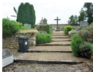
Allée en stabilisé (ou gravillons) avec bordurage en bois au cimetière de Fontaine-Chaalis (60).
