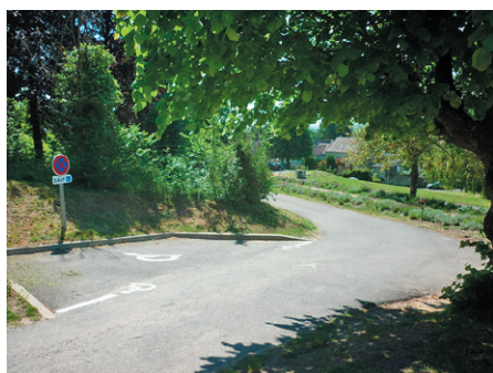
Place PMR près de l'entrée d'un cimetière, séparée du parking disposé à distance plus bas. La place n'est cependant pas idéalement située car vraiment en dévers !
