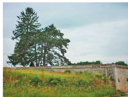
Le cimetière de Bray à Rully (60) présente un mur traditionnel en pierre qui, le long de la route, devient un bel ouvrage de soutènement remarquable et souligne les arbres comme repère dans le paysage.
