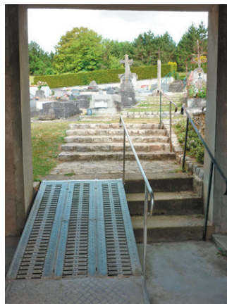
Le cimetière de Tessancourt (95) présente, en raison des pentes naturelles, une configuration complexe pour aménager l'accessibilité PMR. Les emmarchements sont bien visibles et accompagnés de mains-courantes. L'escalier est annoncé par des dalles podotactiles, une rampe amovible a été installée à l'entrée située en bas du cimetière et un parking a été aménagé avec un accès direct en haut du cimetière.
