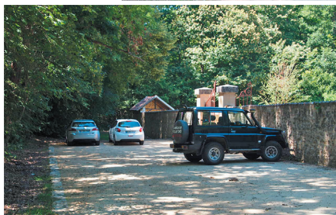
Stationnement devant le cimetière de Boissettes (77). L'accès en enrobé a été décroûté au profit d'une aire en stabilisé renforcé. Les bordures en pavés de grès sont arasées, ce qui permet de récolter les eaux pluviales dans un fossé latéral très doux.
