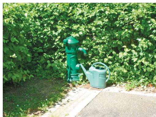
Au cimetière de Guyancourt (78), un dispositif régulièrement rencontré : une fontaine traditionnelle en fonte disposée aux angles des carrés du cimetière et associée à un avaloir pour récupérer les eaux.
