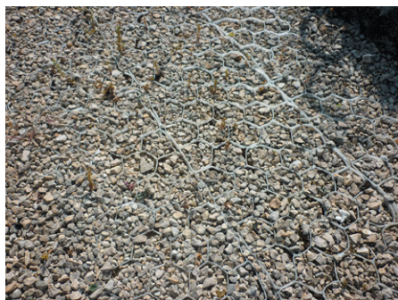
Sol en gravillon maintenu par une nappe alvéolaire dans une allée du cimetière de Montreuil (93).
