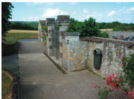
À Courdimanche (95), le cimetière est clos par un mur traditionnel en pierre. Les faces donnant sur l'espace public sont animées par des rosiers grimpants.
