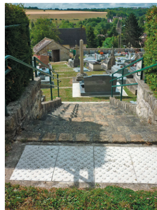
Le cimetière de Tessancourt (95) présente, en raison des pentes naturelles, une configuration complexe pour aménager l'accessibilité PMR. Les emmarchements sont bien visibles et accompagnés de mains-courantes. L'escalier est annoncé par des dalles podotactiles, une rampe amovible a été installée à l'entrée située en bas du cimetière et un parking a été aménagé avec un accès direct en haut du cimetière.
