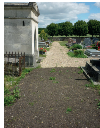
Sol en bois déchiqueté à Corneilles-en-Vexin (95). C'est une bonne solution de sol drainant, confortable et peu coûteux. Pour éviter la repousse des herbes il faut assurer un régallage tous les ans.
