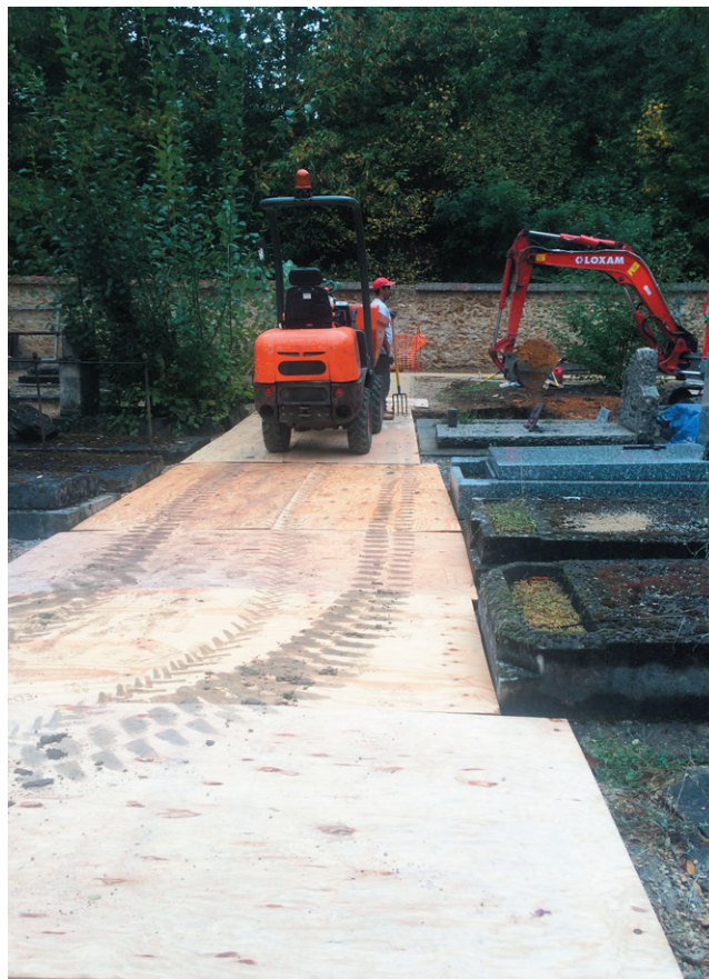
Mise en place de plaques de contre-plaqué par l'entreprise de fossoyage. Cimetière de Boissettes (77).
