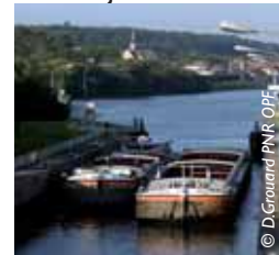
Ecluse sur l'Oise à Pont Sainte-Maxence
