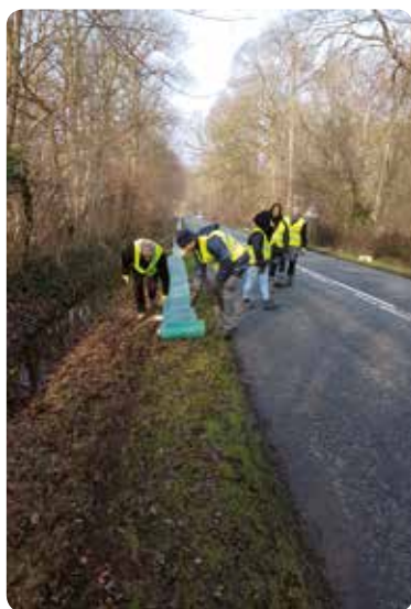
Installation du dispositif de protection à La Chapelle-en-Serval par des bénévoles et le Chantier d'insertion.
