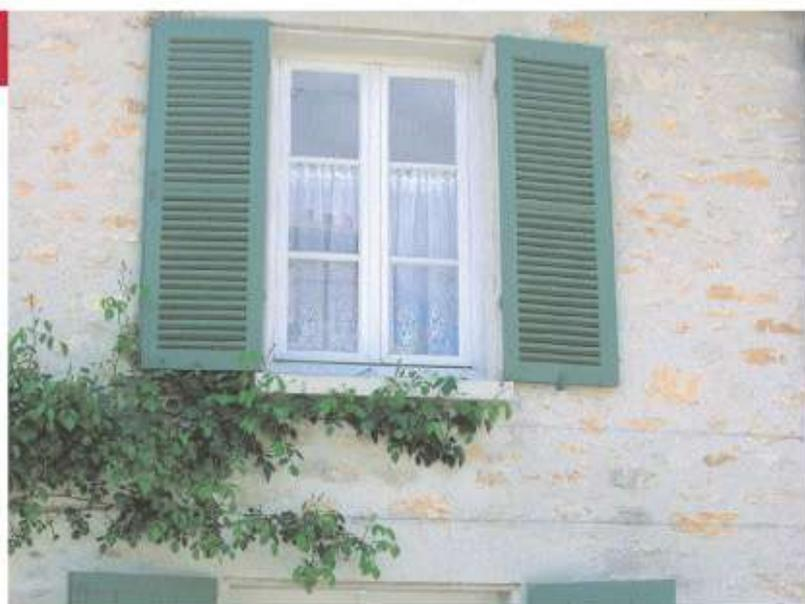
Les volets battants des fenêtres s'encastrent dans les feuillures ménagées à l'extérieur des tableaux. Pour les habitations les plus modestes, les volets sont réalisés en bois peint non verni sous forme de planches assemblées par des barres horizontales sans écharpe. Les volets en bois peuvent être persiennés (sur la moitié de leur hauteur au rez-de-chaussée, en totalité à l'étage).
