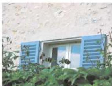
L'encadrement de la fenêtre était alors souligné par une finition en enduit lissé d'un ton plus clair que l'enduit de la façade. Parfois, le linteau en bois est apparent, il peut être peint avec un lait de chaux l'harmonisant avec le ton de la maçonnerie. Les appuis de baies sont réalisés traditionnellement avec une pierre monolithe en débord ou plusieurs pierres.
