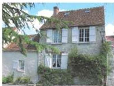
La brique est rarement présente, les chaînages et encadrements de baies sont réalisés en pierre de taille. On observe des bandeaux et des corniches en plâtre, pierre ou brique. Un enduit bâtard taloché protège parfois la partie basse du mur formant un soubassement.
