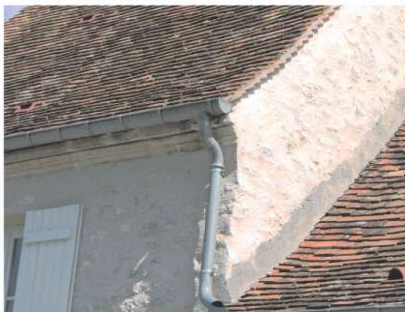
Les enduits sont appliqués soit partiellement (enduit de restauration à pierre-vue avec des joints arasés au nu de la maçonnerie), soit totalement (enduit couvrant au mortier de chaux grasse ou au plâtre gros, selon les cas). Parfois, ces enduits couvrants sont teintés en ocre jaune.
