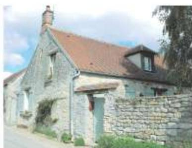
La construction forme un parallélepède rectangle étroit et de plain-pied, surmonté d'un toit à deux pentes à 45°, encadré par des souches de cheminées établies dans le prolongement des pignons. Sa hauteur au faitage est comprise entre 6 et 7 mètres depuis le sol. Sa longueur varie de 13 à 18 mètres et sa largeur de 5 à 7 mètres. Des annexes peuvent être accolées à ce volume principal.
