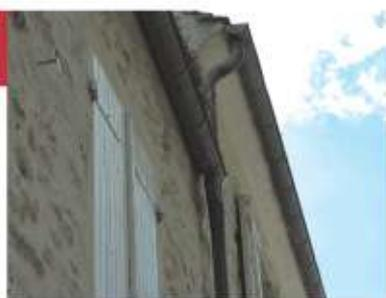
Sur les murs de moellons, harpes et chaînage d'angle en pierre de taille viennent renforcer la maçonnerie. Un soubassement en enduit bâtard lissé protège parfois le pied du mur contre les infiltrations et les rejaillissements d'eau pluviale.
