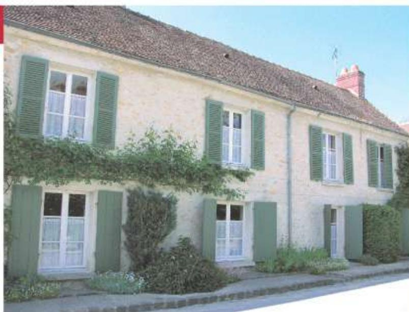
Les façades sur rue sont généralement ordonnancées : alignement horizontal des linteaux et des appuis, superposition et hiérarchisation des fenêtres. Par leurs couleurs, volets et portes habillent la façade en harmonie avec le ton des moellons, des briques et de l'enduit.
