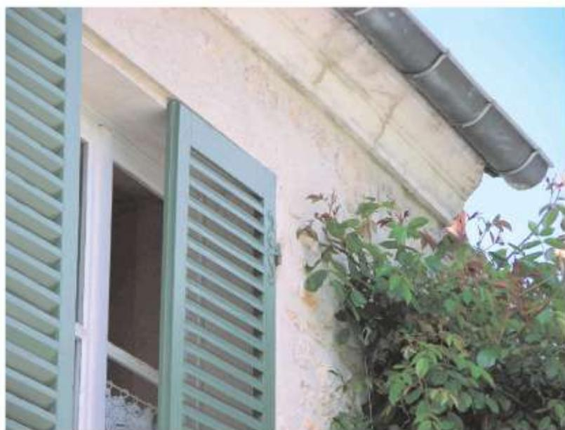
Les ouvertures dans les murs, facteurs de fragilité, font l'objet de nombreux détails. Les linteaux en bois et les piédroits maçonnés étaient le plus souvent destinés à être enduits.
