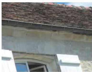
Quand l'encadrement est en pierre de taille appareillée, celui-ci n'est pas enduit. Les encadrements de fenêtre présentent des aspects variés et parfois un profil légèrement cintré.
