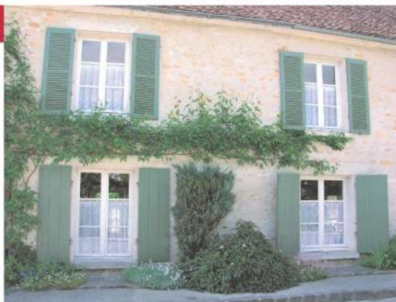
Des feuillures permettent d'encastrer les volets dans le tableau des fenêtres afin qu'ils ne donnent pas prise au vent.
