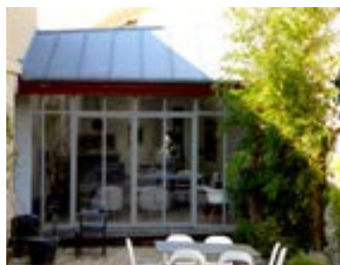
Extension dans une cour formant une veranda couverte en zinc, archi. d'intérieur J-D. Goulin
