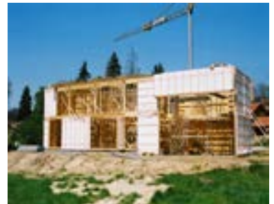
Chantier d'une maison à ossature bois
