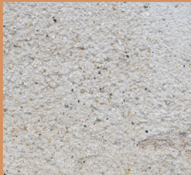
Enduit couvrant à texture grossière
