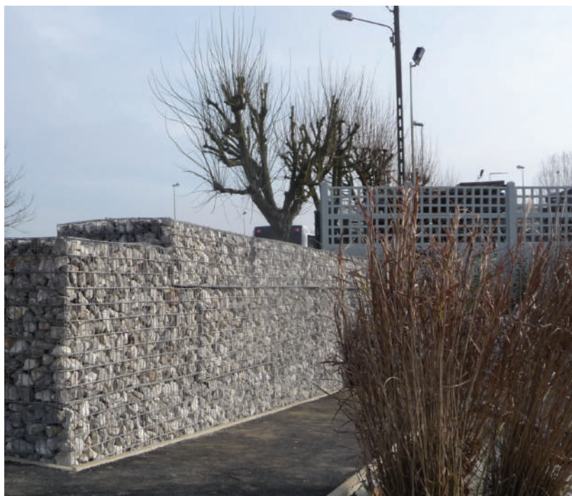
Clôture technique en gabion d'une zone d'activités à Fosses
