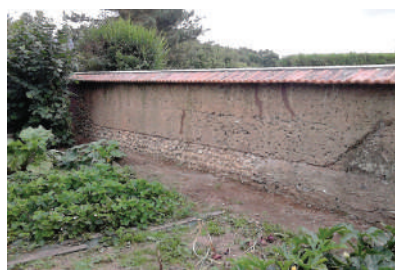
Mur de clôture en pisé
