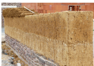
Mur en bauge en cours de construction
