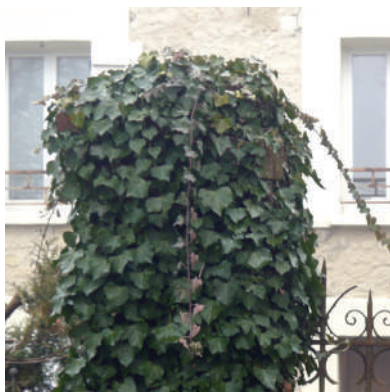
Dévégétaliser les piles et murets
