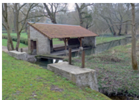
Le lavoir et les vannes d'inondation
