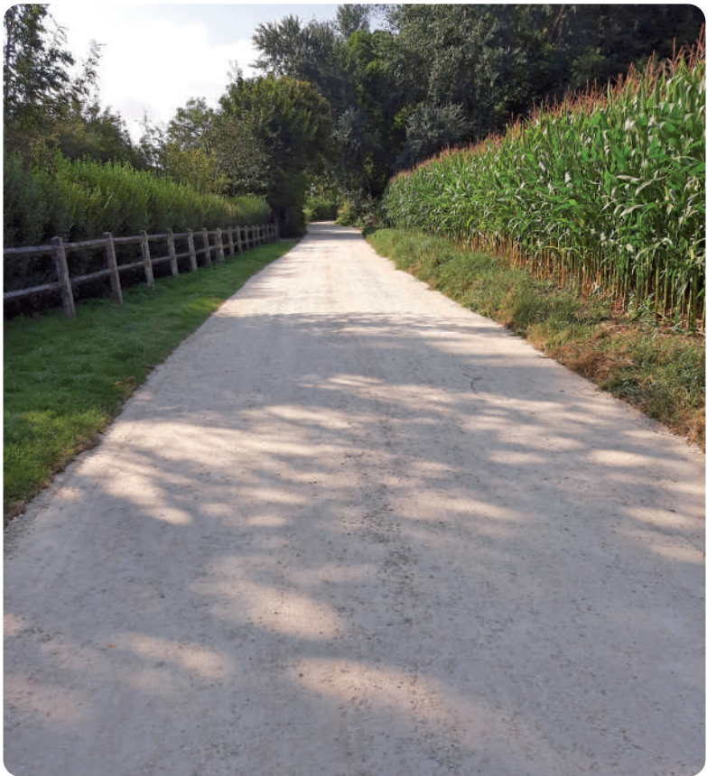
Chemin après rénovation
