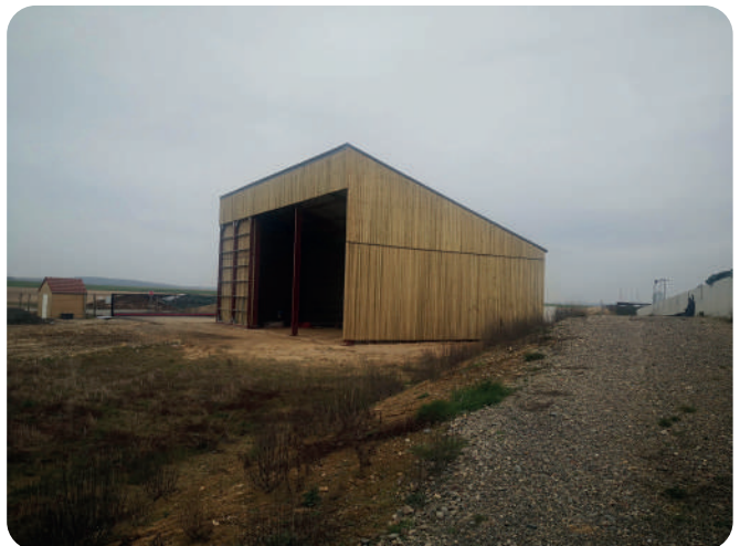
Intégration paysagère d'un bâtiment de stockage par un bardage bois
