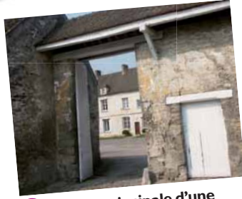
2 Entrée principale d'une cour de ferme.
