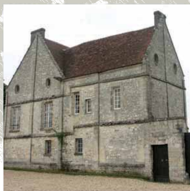
▲ Ferme de l'ère industrielle à Beaulieu-le-Neuf
