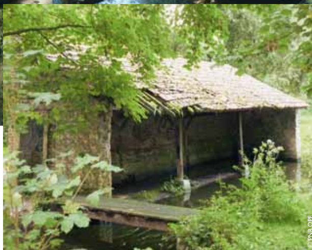
▲ Lavoire de Mont-l'Évêque, après et avant restauration.
