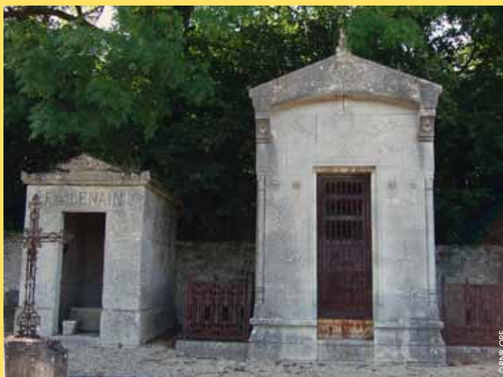
▲ Chapelles funéraires de Courteuil avant restauration.
