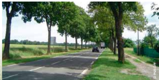
▲ Alignement d'arbres sur la RD 932.
