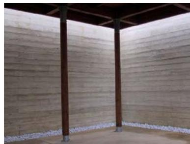
Abri composé de murs et sol en béton clair avec un fossé de gravillons qui reçoit les eaux de pluie provenant de l'ouverture entourant la toiture apportant un éclairage naturel
