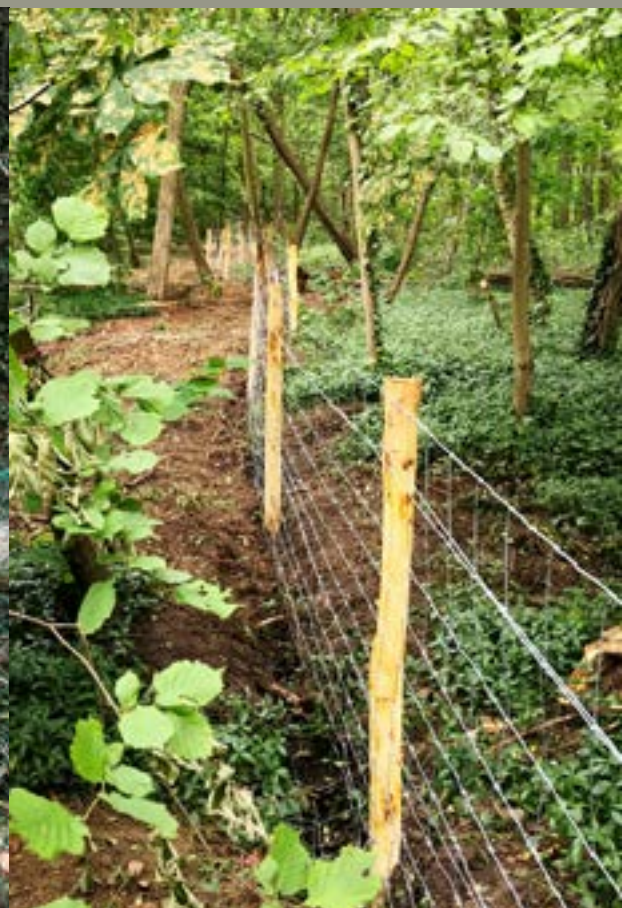
Travaux sur les clôtures du parc du château : avant/après
