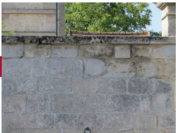
Ce mur en pierre de taille a été réalisé avec un calcaire tendre gélif. La pierre s'effrite et se dégrade (alvéolisation et desquamation)
