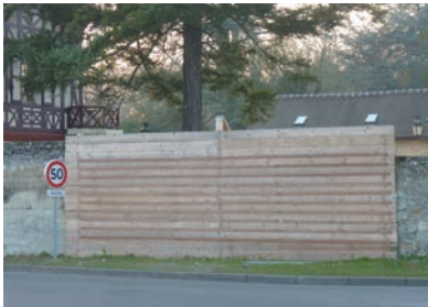
Une palissade bois assure temporairement le rôle de masque de la partie effondrée
