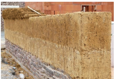
Mur en bauge en cours de construction
