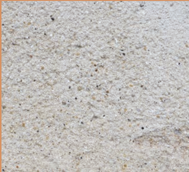
Enduit couvrant à texture grossière
