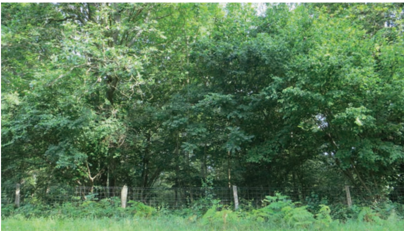
Un grillage fixé à des piquets de châtaigner est une clôture discrète pour cette parcelle forestière, ici à Béthemont-la-Forêt
