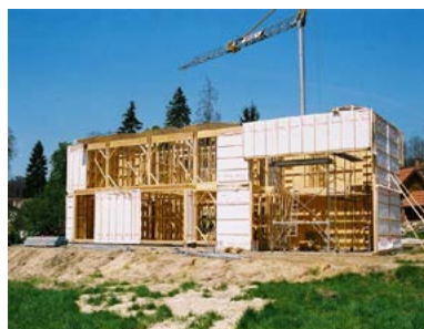
Chantier d'une maison à ossature bois
