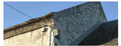
Pignon d'un corps de ferme avec des pas de moineaux
