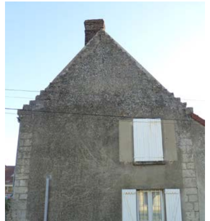
Pignon d'un corps de ferme avec des pas de moineaux
