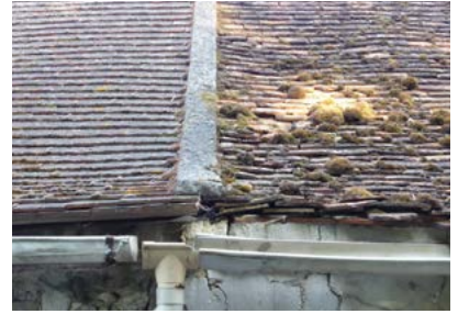
Ruellées, solins, ou ouvrages de décors (crête, mitron de terre cuite), façons et détails de pose de tuiles animent les toitures.
