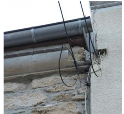
Profil mouluré d'une corniche enduite sur support moellonné.
