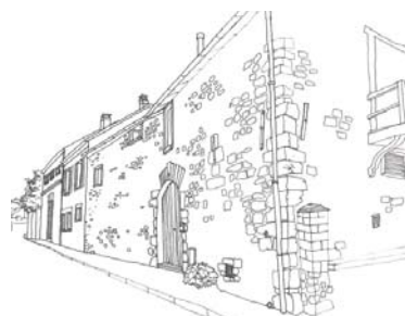
Les murs des maisons rurales, au fruit parfois prononcé, présentent des chaînages d'angle en pierre de taille
