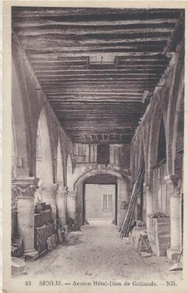
Bâtiment principal de l'hôtel-Dieu : nef centrale et bas-côté nord - ouest
