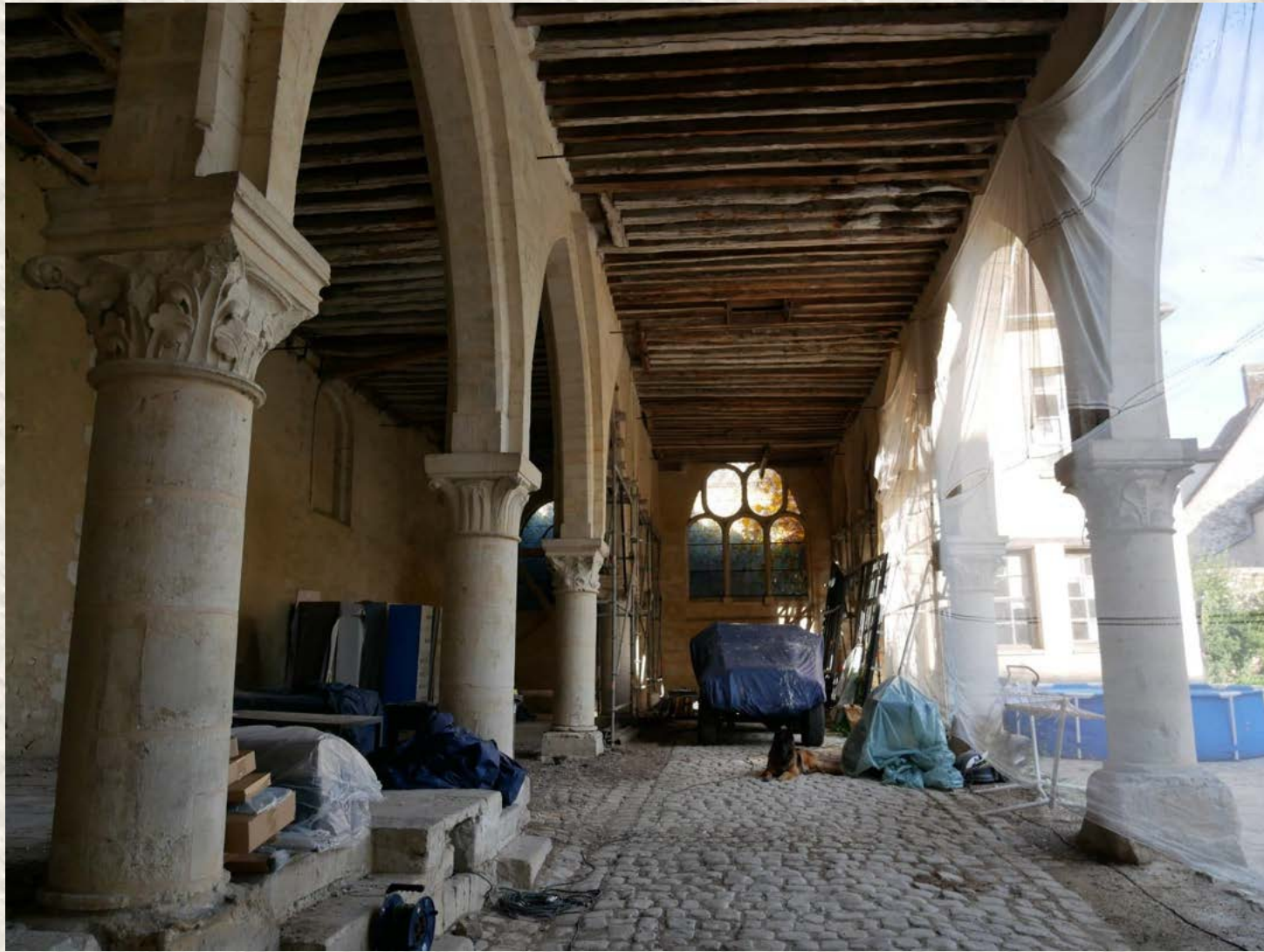
Bâtiment principal de l'hôtel-Dieu : nef centrale et bas-côté nord - est
