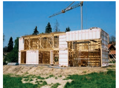
Chantier d'une maison à ossature bois
