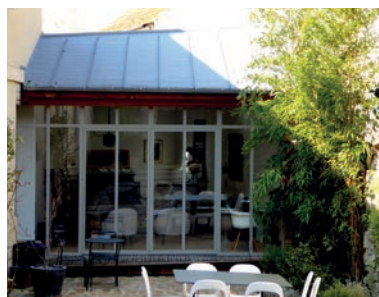
Extension dans une cour formant une veranda couverte en zinc, archi. d'intérieur J-D. Goudalin
