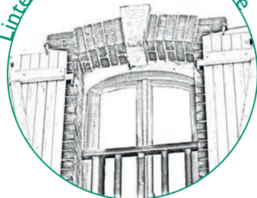
Linéau cintré brique et pierre
