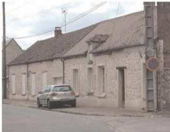
La construction forme un parallélepède rectangle étroit et de plain-pied, surmonté d'un toit à deux pentes à 45°, encadré généralement par des souches de cheminées établies dans le prolongement des pignons. Sa hauteur au faitage est comprise entre 6 et 9 mètres depuis le sol. Sa longueur varie de 7 à 18 mètres et sa largeur de 5 à 7 mètres. Des annexes peuvent être accolées à ce volume principal.
