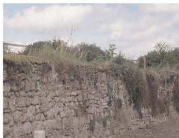
Certains murs de bâtiments annexes et de clôture dévoilent un appareillage de qualité composé de moellon assisé, parfois de pierre plate, posés à sec. En pied de mur, la végétation peut assainir les maçonneries. Les clôtures végétales constituées d'arbustes d'essences locales constituent un moyen simple et naturel pour préserver l'intimité et assurer une transition avec le paysage naturel environnant.
