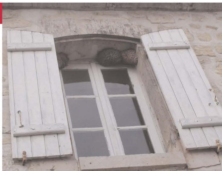
Les volets battants des fenêtres s'encastrent dans les feuillures ménagées à l'extérieur des tableaux. Ils sont réalisés en bois peint non verni sous forme de planches assemblées par des barres horizontales sans écharpe. Les volets peuvent être persiennés (c'est à dire à claire-voie) sur la moitié de leur hauteur au rez-de-chaussée, en totalité à l'étage.
