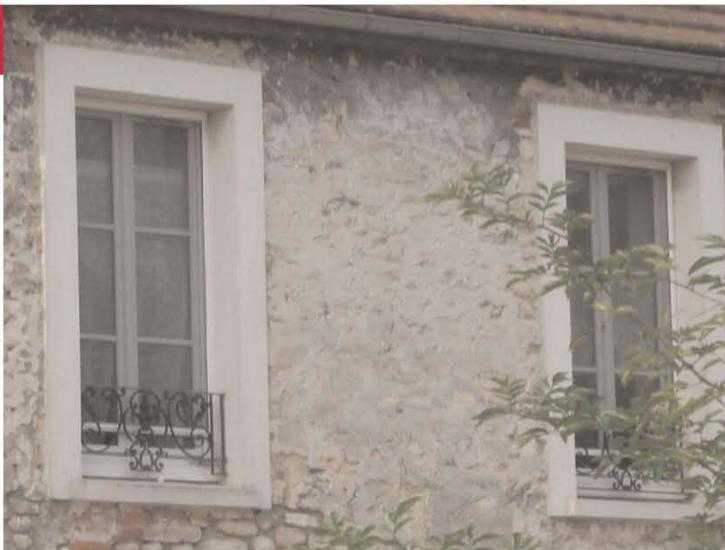
Les éléments de ferronnerie sont présents sur les fenêtres des maisons de Barbery. On note parfois des garde-corps à l'étage des maisons de bourg. Ils prennent la forme de simples lices ou d'ouvrages en fer forgé et en fonte. Des feuillures permettent d'encasturer les volets dans le tableau des fenêtres afin qu'ils ne donnent pas prise au vent.
