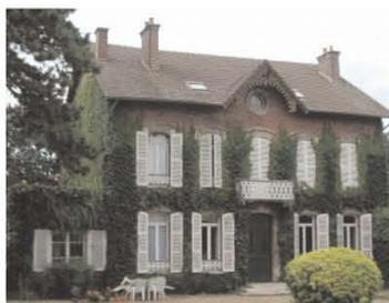
La construction forme un parallépipède rectangle de dimensions variables surmonté d'un toit à deux pans dont la pente est souvent inférieure à 45°. Elle est étroite sur deux niveaux. La toiture est couverte en tuile mécanique rouge (appelée tuile de Beauvais). Les souches de cheminées massives en brique sont établies dans le prolongement des pignons.
