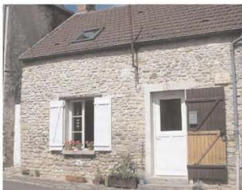
Tuile plate, grès, moellon calcaire enduit sont les matériaux de construction traditionnels des maisons rurales.
