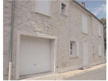
Les maisons de bourg se caractérisent par des murs de moellon calcaire et grès encore parfois enduits. Des pierres de taille structurent les murs notamment pour les chaînages, les encadrements, les harpes.
