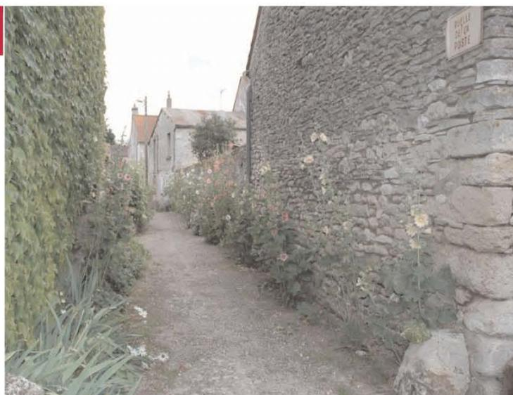
La couleur du mortier se rapproche de celle de la pierre. Elle prend une plus grande importance visuelle sur les murs en moellon que sur les murs en pierre de taille où les joints sont minces et à peine apparents.
