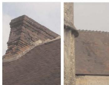
Les couvertures traditionnelles de Barbery sont en tuile plate de petit moule (60 à 80 au m<sup>2</sup> environ), le faîtage est scellé au mortier clair avec des tuiles demi-rondes (faîtage à crêtes et embarrures). Les rives sont souvent protégées par un solin de plâtre appelé la ruellée ou rarement en ardoise. Celle-ci empêche la pluie de s'infiltrer sous la toiture.
