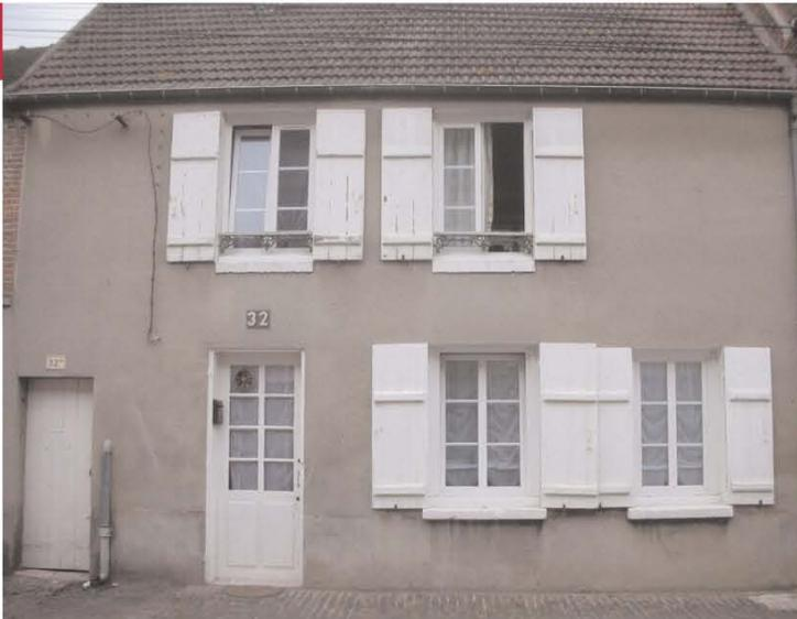
Les façades sur rue sont généralement ordonnancées : alignement horizontal des linteaux et des appuis, superposition et hiérarchisation des fenêtres. Par leurs couleurs, volets et portes habillent la façade en harmonie avec le ton de l'enduit, ainsi que les tonalités chaudes du grès ou du calcaire.
