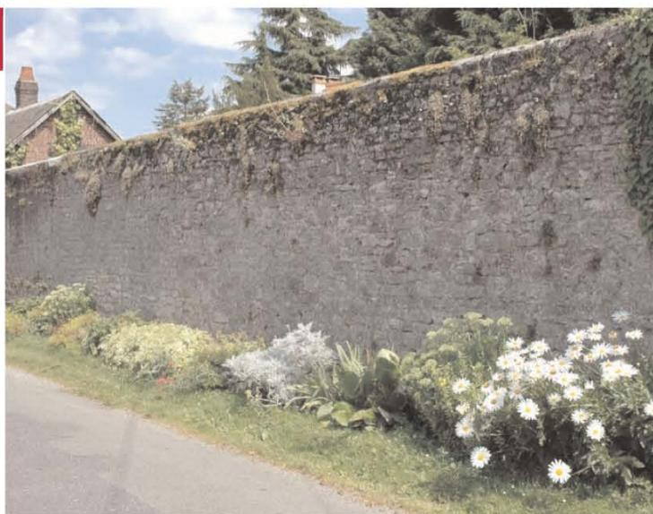
Ces murs étaient autrefois très ouvragés : tête de mur protégée par un chaperon convexe de moellon, une dalle de pierre en saillie, ou quelques rangs de tuile plate pour rejeter les eaux de pluie. Lorsque les murs présentent une certaine longueur, des jambes harpées et des chaînages les consolident.
