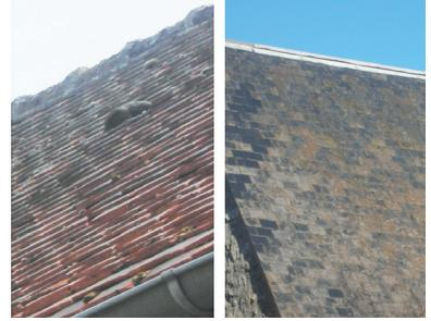
Les couvertures traditionnelles de Brasseuse sont en tuile plate de petit moule (60 à 80 au m<sup>2</sup> environ), le faîtage est scellé au mortier clair avec des tuiles demi-rondes (faîtage à crêtes et embarrures).
