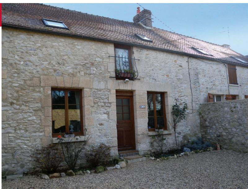
La façade était protégée par un enduit recouvrant les moellons. Ce revêtement teinté est habillé par des bandeaux et encadrements en pierre calcaire.
