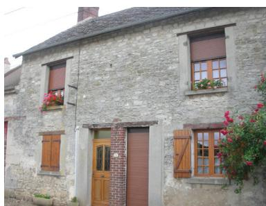
La construction forme un parallépipède rectangle de dimensions variables surmonté d'un toit à deux pans proche de 45°. Les souches de cheminée sont positionnées dans le prolongement des pignons ou au niveau des murs de refend.
