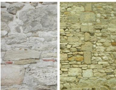
Certains murs de pignons, de clôtures sont construits avec une mise en œuvre proche de la pierre sèche (sans mortier ou presque) avec des pierres plus ou moins plates en calcaire ou grès.
