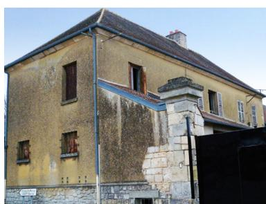
Les murs en moellon calcaire sont recouverts totalement par un enduit à la chaux. Les chaînages et encadrements de baies sont réalisés en pierre de taille. Certaines façades sont dépourvues de leur enduit et présentent des murs à pierres vues.
