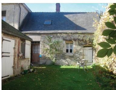
La construction forme un parallélepède rectangle de plain-pied, surmonté d'un toit à deux pans, avec des pentes comprises entre 35° et 45° ; les souches de cheminée sont généralement en brique.
