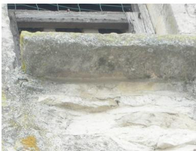
L'encadrement de la fenêtre est constitué de pierre de taille, de plâtre ou d'un enduit lissé.
