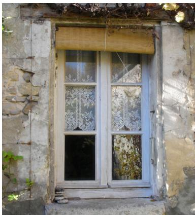
Les fenêtres sont plus hautes que larges. Les linteaux sont droits, exceptionnellement cintrés, ils sont en pierre ou en bois recouvert d'un enduit, plus rarement en brique ou en métal.
