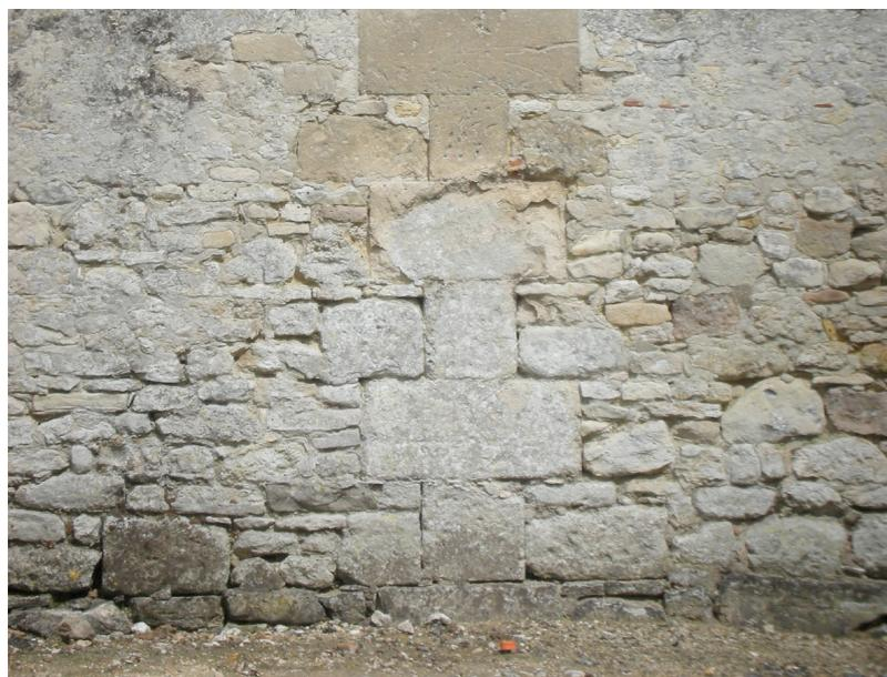
Sur les murs de moellon, chaînages, encadrements et appuis de fenêtre, en pierre de taille, structurent la maçonnerie. Les chaînes des hauts murs sont constituées par des blocs de grandes dimensions. Les encadrements en pierre renforcent les ouvertures dans les murs, facteurs de fragilité.
