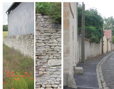
Les murs sont montés avec de la pierre de taille, du moellon calcaire et quelques grès.
