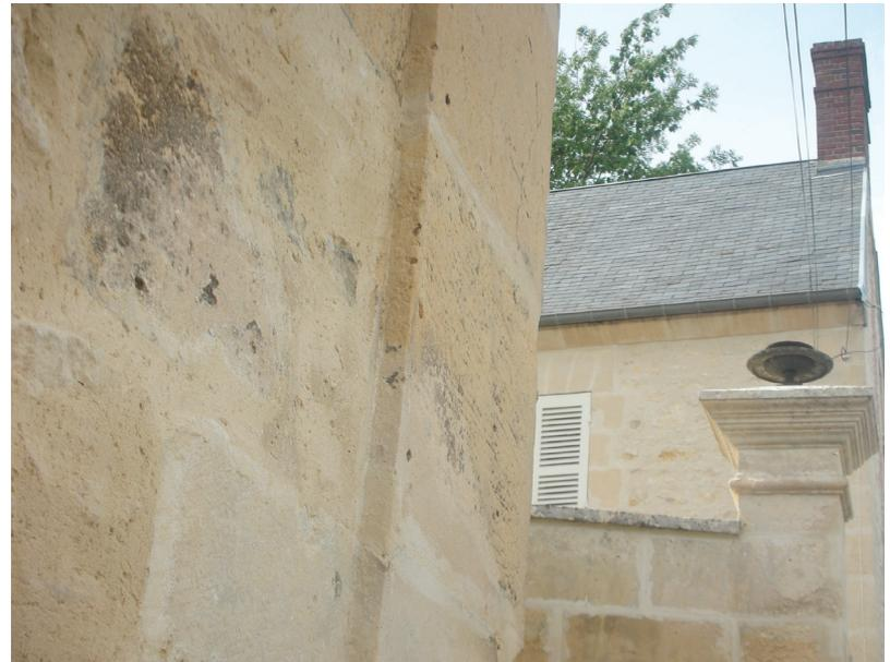
Les enduits sont appliqués soit partiellement (enduit de restauration à pierre- vue avec des joints arasés au nu de la maçonnerie), soit totalement (enduit couvrant au mortier de chaux ou au plâtre, selon les cas).
