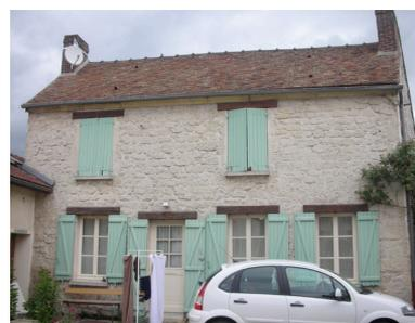
Portes et fenêtres sont disposées selon un certain ordonnancement sur la façade. Elles n'occupent qu'une surface réduite de la façade, laissant entre elles, surtout à l'étage, des parties de mur plein, appelées trumeaux. Les fenêtres à engranger sont souvent positionnées dans l'axe des baies du rez-de-chaussée.
