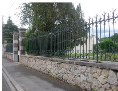
Les clôtures sont parfois composées d'un mur bahut et d'une ferronnerie à barreaudage vertical. Les piles de portail sont en pierre ou en brique.
