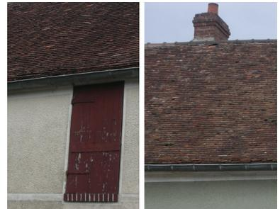
Les couvertures traditionnelles sont en tuile plate petit moule (60 à 80 au m<sup>2</sup> environ), le faitage est scellé au mortier clair avec des tuiles demi-rondes (faitage à crêtes et embarcures).
