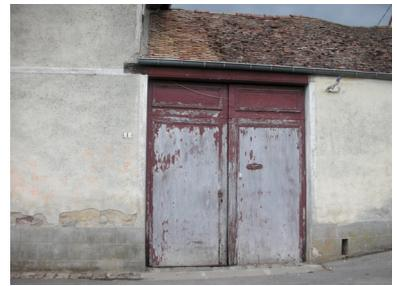
Les portes charretières présentent deux battants réalisés par l'assemblage de planches verticales en bois plein sur ossature.
