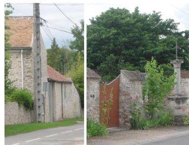
Les murs en pierre sont construits essentiellement avec des blocs de grès, des moellons de calcaire trouvés dans les terres cultivées du village. Ils sont peu enduits, parfois montés avec très peu de mortier ou un mortier maigre qui leur confère un aspect proche de celui de la pierre sèche.
