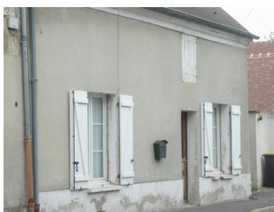
La construction forme un parallépipède rectangle sur deux niveaux dont un à encvement, surmonté en général d'un toit à deux pans à 45°. Des souches de cheminée en brique sont positionnées dans le prolongement des pignons.
