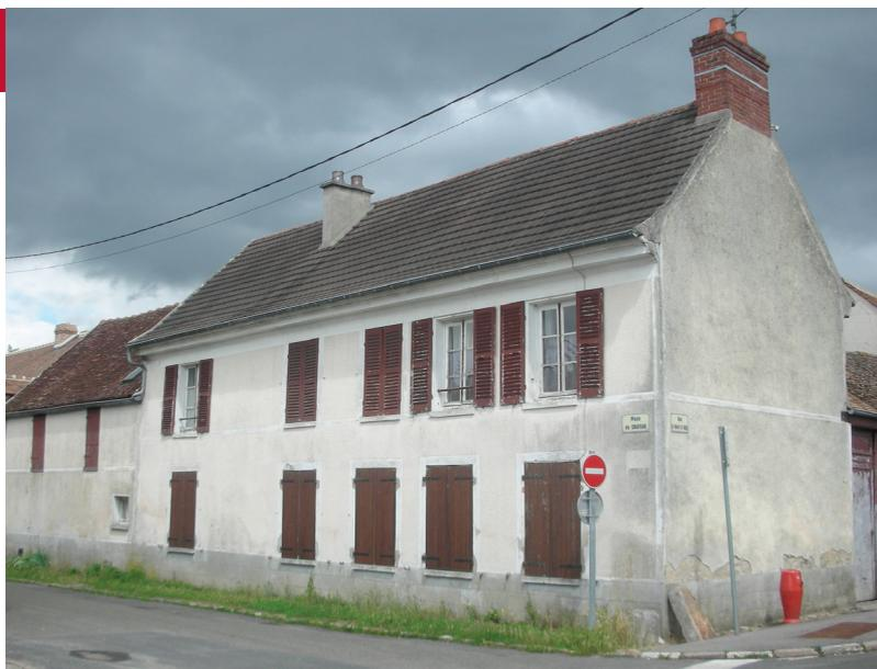
Des volets persiennés sur la partie supérieure au rez-de-chaussée, sur la totalité à l'étage, occultent les fenêtres des maisons de bourg. Les ouvertures de l'étage sont agrémentées de garde-corps en ferronnerie. Des modénatures en finition lissée ornent les murs sur rue. Une corniche en plâtre souligne la liaison entre le toit et le mur.
