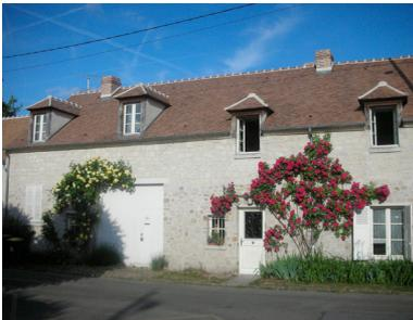
La construction forme un parallépipède rectangle étroit et de plain-pied, surmonté d'un toit à deux pentes à 35°. Des souches de cheminées se trouvent dans le prolongement des pignons ou au niveau des murs de refend.
