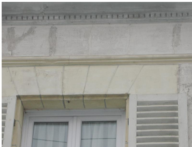
L'encadrement de la fenêtre est parfois constitué de pierre de taille. Des feuillures permettent d'encastrer les volets dans le tableau.
