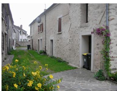
La tuile plate, le moellon calcaire et grès enduits sont les matériaux de construction traditionnels des maisons rurales. Les pignons sont recouverts d'un enduit à pierre vue. Un enduit bâtard protège parfois le soubassement du mur. Les couleurs des volets, des portes, des fenêtres se détachent du ton de l'enduit, de la pierre et des tuiles de la couverture.
