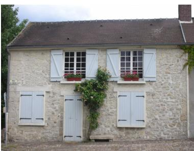
La tuile plate, le moellon calcaire et le grès enduits totalement ou partiellement (enduit à pierres vues) sont les matériaux de construction traditionnels des longères. Les murs sont sobres, dépourvus de modénature.
