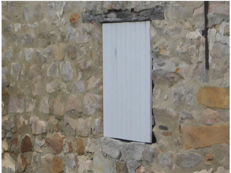
À l'origine, les enduits étaient couvrants au mortier de chaux ou mélangé avec du plâtre gros, selon les cas. Quelques têtes saillantes de moellon grès restaient visibles sur certains murs, mais les pierres calcaires devaient être protégées par un enduit.
