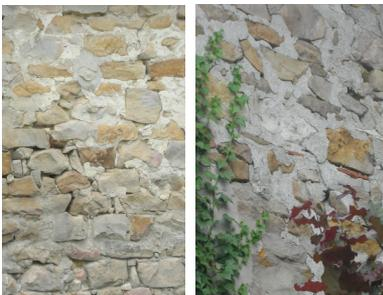
Les murs de clôture sont réalisés, le plus souvent, en moellon calcaire et grès. Brique silico-calcaire et argile sont présentes ponctuellement sur les piles des murs de clôture.
