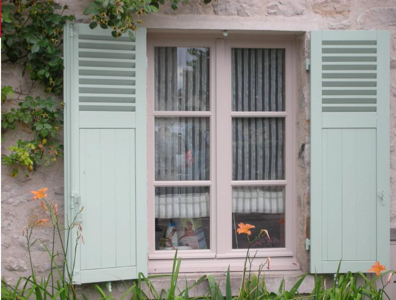
Les volets battants en bois peuvent être persiennés sur la moitié de leur hauteur au rez-de-chaussée, en totalité à l'étage.
