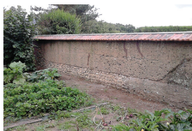
Mur de clôture en pisé
