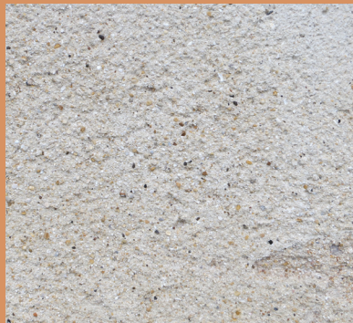
Enduit couvrant à texture grossière
