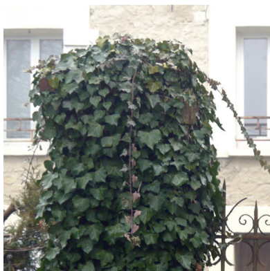
Dévégétaliser les piles et murets
