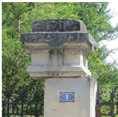
Recaler les pierres de chapiteau
