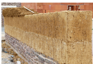
Mur en bauge en cours de construction
