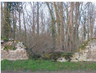
Un mur laissé en l'état après effondrement
