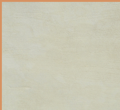
Enduit couvrant étiré à la taloche
