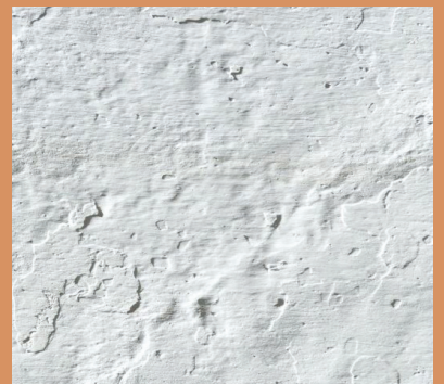
Badigeon au lait de chaux
