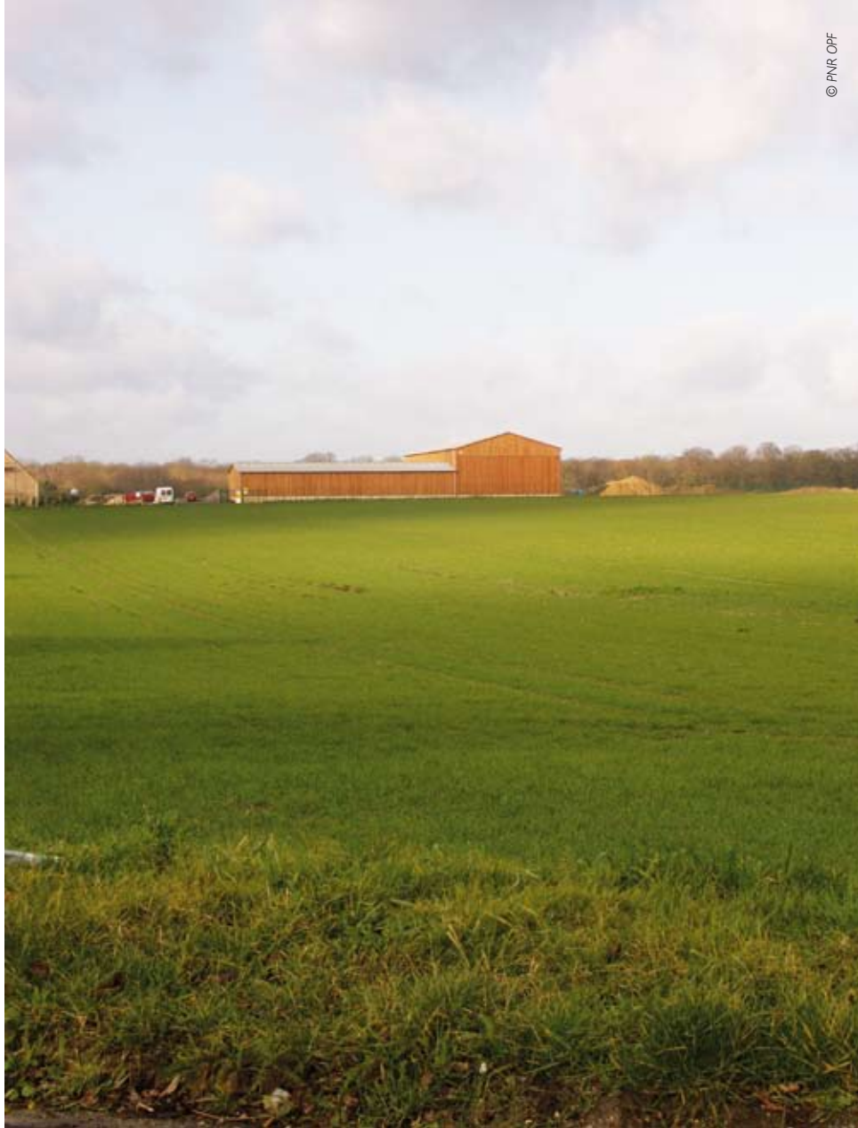
Construction d'un bâtiment agricole à Orry-la-Ville.
