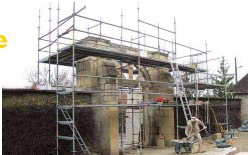
Portail de Senlis pendant la restauration.
