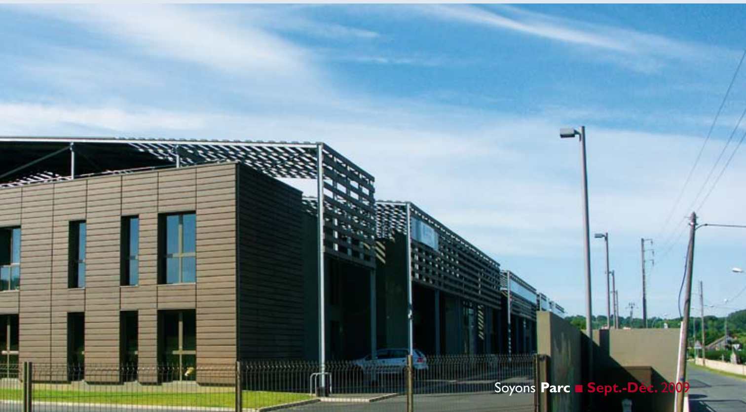
Un bâtiment d'entreprises réalisé par la communauté de communes du Pays de France qui a choisi de réhabiliter une friche plutôt que de développer une zone d'activités.
