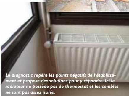
Le diagnostic repère les points négatifs de l'établissement et propose des solutions pour y répondre. Ici le radiateur ne possède pas de thermostat et les combles ne sont pas assez isolés.
