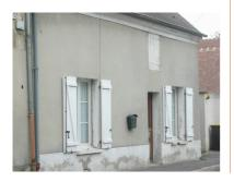
La construction forme un parallélépipède rectangle sur deux niveaux dont un à encuvement, surmonté en général d'un toit à deux pans à 45°. Des souches de cheminée en brique sont positionnées dans le prolongement des pignons.
