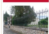
Les murs en pierre sont construits essentiellement avec des blocs de grès, des moellons de calcaire trouvés dans les terres cultivées du village. Ils sont peu enduits, parfois montés avec très peu de mortier ou un mortier maigre qui leur confère un aspect proche de celui de la pierre sèche.
