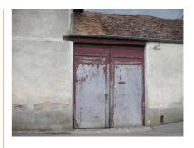
Les portes charretières présentent deux battants réalisés par l'assemblage de planches verticales en bois plein sur ossature.
