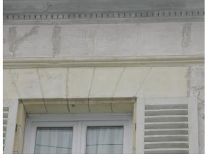
L'encadrement de la fenêtre est parfois constitué de pierre de taille. Des feuillures permettent d'encastrer les volets dans le tableau.
