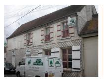
Les murs sont en pierre calcaire et grès, les couvertures en tuile plate. Corniche, bandeaux et encadrements sont en plâtre ou en pierre. Parfois ces modénatures et le soubassement sont en enduit de chaux lissé.
