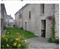
La tuile plate, le moellon calcaire et grès enduits sont les matériaux de construction traditionnels des maisons rurales. Les pignons sont recouverts d'un enduit à pierre vue. Un enduit bâtard protège parfois le soubassement du mur. Les couleurs des volets, des portes, des fenêtres se détachent du ton de l'enduit, de la pierre et des tuiles de la couverture.
