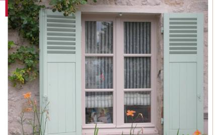
Les volets battants en bois peuvent être persiennés sur la moitié de leur hauteur au rez-de-chaussée, en totalité à l'étage.
