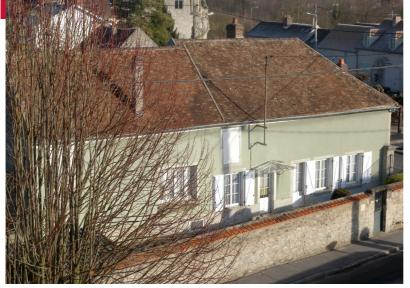
La façade était habituellement protégée par un enduit couvrant. Ce revêtement teinté est réhaussé par des bandeaux, harpes et encadrements clairs lissés. Les corniches étaient généralement réalisées en plâtre.
