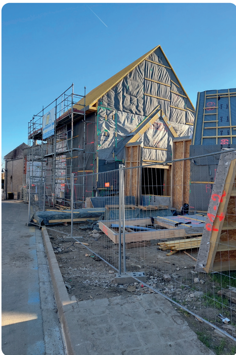
Construction de la mairie de Ver-sur-Launette en ossature bois et isolation paille
