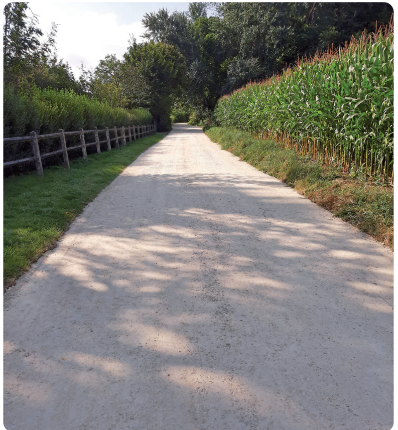
Chemin après rénovation
