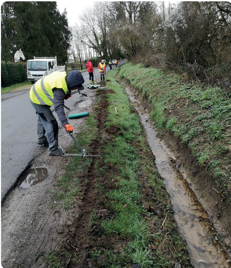
Installation dispositif de protection des amphibiens à Plailly
